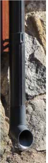
Stuprören till vänster har traditionell utformning med skarpa vinklar. Stupröret till höger har en modernare svängd form som inte rimmar med husets karaktär, det får ändå vara kvar till dess det är tekniskt motiverat med ett byte.
