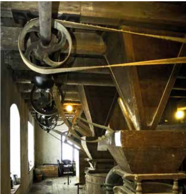
Kvarnbyggnadens bottenplan inrymmer kvarnrummet med kvarnstenarna. Säden släpps ner från vindsplanet via stora trätrattar till kvarnstenarna där den mals. Kanaans Väg 53, Grimsta.
