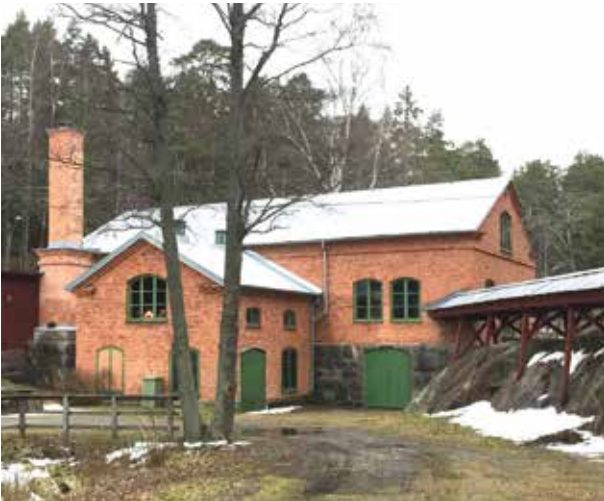
Den lägre utbyggnaden inrymde från början en spannmålstork. Idag används bottenplanet som café vid kvarndagarna, då kvarnarna dras igång för besökare. Till höger syns transportverket mellan kvarnbyggnaden och magasinet.
