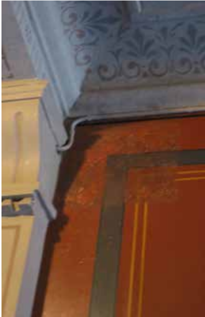
Vid renovering av en portik mellan gata och gård har en bit av ett framskrapat ursprungligt färglager sparats. Högbergsgatan 12, Södermalm.
