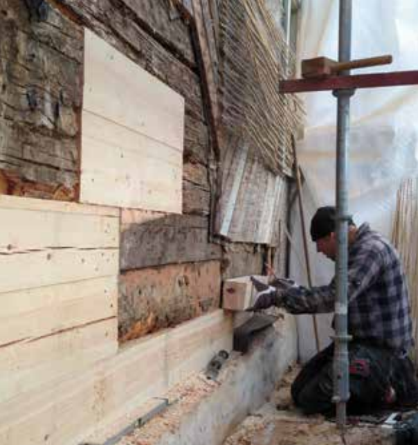
Träkonstruktioner erbjuder goda möjligheter att endast byta ut skadade delar. Vid reparation eller underhåll kan nytt virke skarvas i – hellre lappa och laga än att ersätta stora partier. Flygelbyggnaden på Ängby gård, Norra Ängby.
