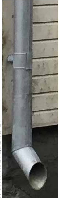
Stuprören till vänster har traditionell utformning med skarpa vinklar. Stupröret till höger har en modernare svängd form som inte rimmar med husets karaktär, det får ändå vara kvar till dess det är tekniskt motiverat med ett byte.
