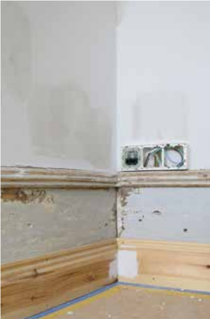
Vid renoveringar och ommålning ses snickerierna över. Eventuella skador repareras. Vid behov byts skadade delar ut mot nyttillverkade. Snickerierna målas sedan på traditionellt vis. Vid stora ombyggnader dras elen om. Nya dragningar utförs gärna utanpåliggande. Svartensgatan 31, Södermalm.
