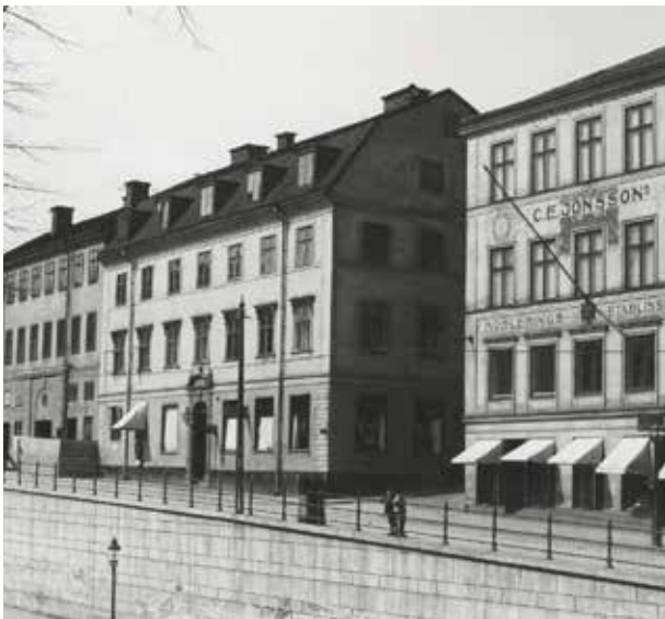
FOTO SSM C594
