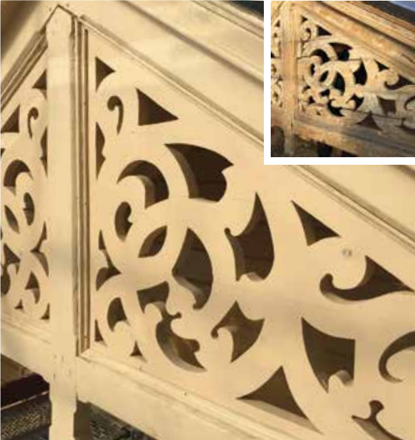
Till slut kan en byggnadsdel behöva bytas för att den inte längre går att renovera. Här har en av flera likadana gavelspetsar varit så skadad att lösningen varit att tillverka en ny. Övriga har kunnat renoveras. Villa Lyran, Älgrytevägen 90, Bredäng.
