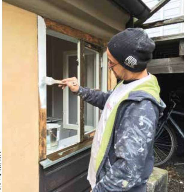
Fönstren renoveras i stället för att bytas ut, oavsett om det är äldre fönster eller fönster från 1970–80-talet. Trälagningar, passning och justering görs. Lagningsnitt läggs så att vatten inte kan tränga in. Yttersta Tvärgränd 10, Södermalm.
