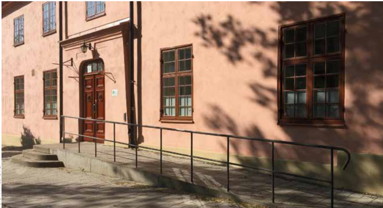
Tillägg kan behövas för att uppfylla nutida krav, hyresgäst Anpassningar eller behov av ökad tillgänglighet. En ramp bör utformas så att den blir ett diskret tillägg i den historiska miljön. Eastmansvägen 35, Vasastaden.
