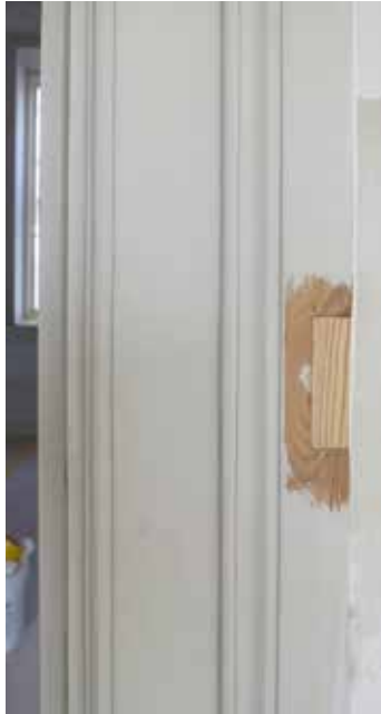
Vid renoveringar och ommålning ses snickerierna över. Eventuella skador repareras. Vid behov byts skadade delar ut mot nyttillverkade. Snickerierna målas sedan på traditionellt vis. Vid stora ombyggnader dras elen om. Nya dragningar utförs gärna utanpåliggande. Svartensgatan 31, Södermalm.
