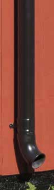
Stuprören till vänster har traditionell utformning med skarpa vinklar. Stupröret till höger har en modernare svängd form som inte rimmar med husets karaktär, det får ändå vara kvar till dess det är tekniskt motiverat med ett byte.
