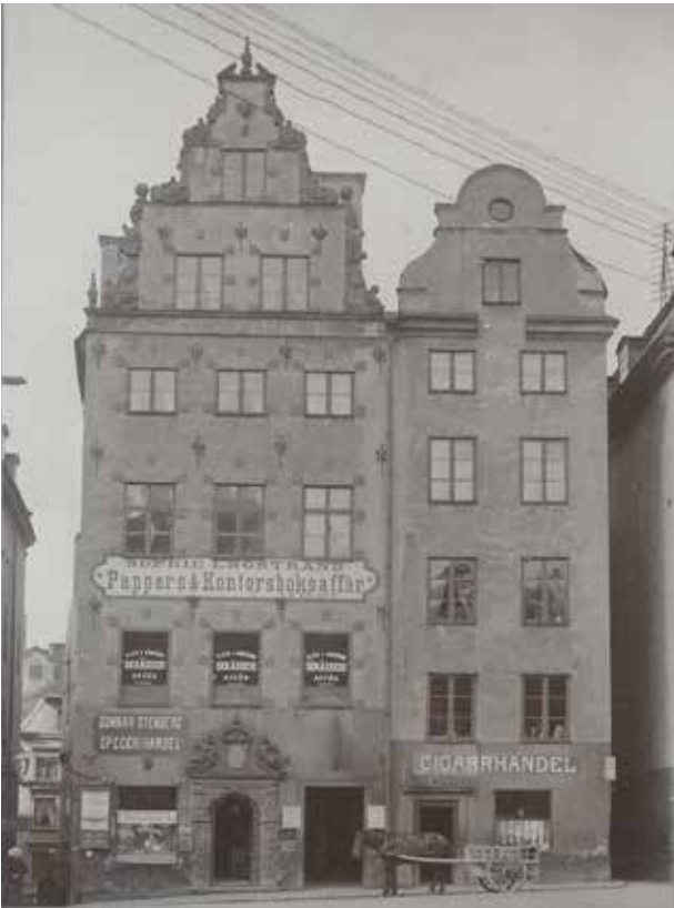
Bild kring 1900. Det högra huset har kvar medeltida murverk upp till tre våningars höjd. Under 1860-talet gjordes en öppning mellan byggnaderna för att använda nr 20:s entré till båda husen.
