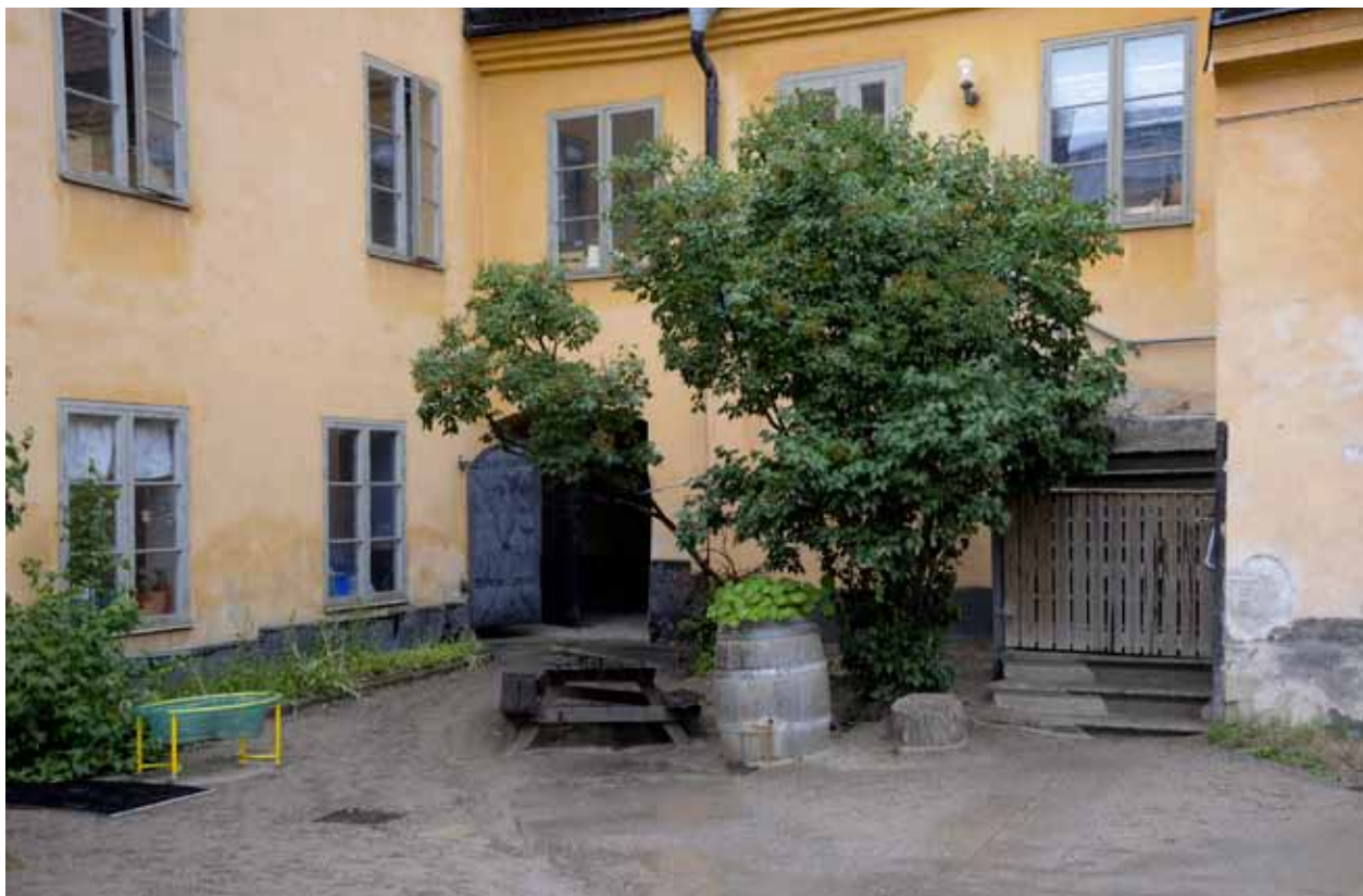
HUS 3 OCH 5 MOT GÅRDEN MED BL.A. EN ÄLDRE JÄRNDÖRR I PORTVALVET. FOTO J. MALMBERG.
