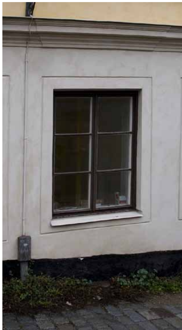
OVAN FÖNSTRET FINNS EN LITEN UTKRAGNING I LISTEN SOM MARKERAR EN URSPRUNGLIG DÖRRÖPPNING. FOTO: J. MALMBERG.
