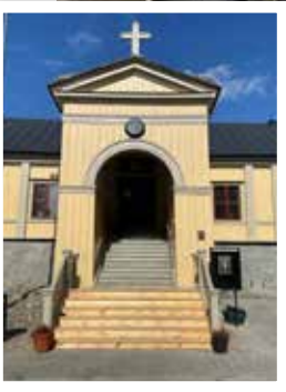
Byggnaden uppfördes på 1720-talet som Sabbaths värdshus, och blev kyrka på 1760-talet.
