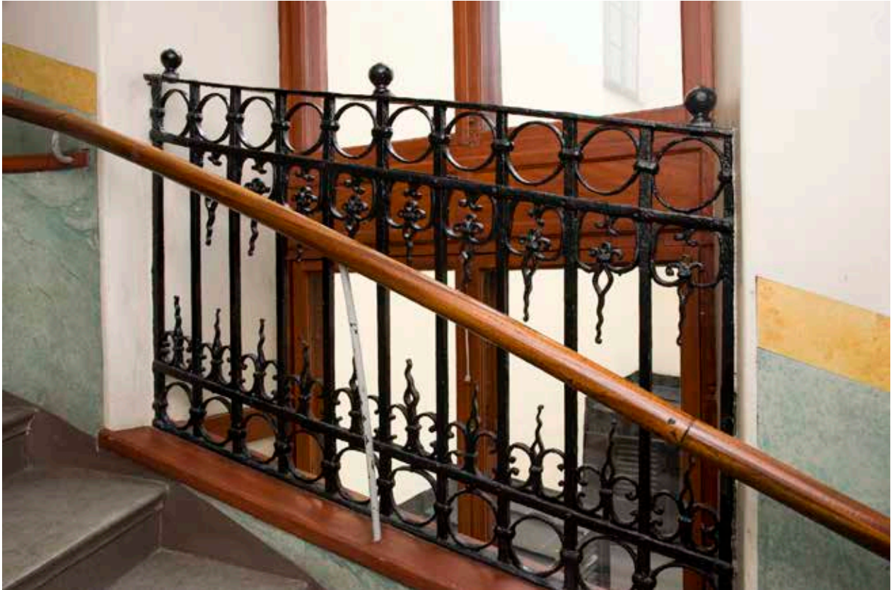
JÄRNÄRÄCKE FRÅN OMKRING 1700 FINNS PÅ TVÅ PLATSER I TRAPPHUSETS ÖVRE DELAR. FOTO: J. MALMBERG.
