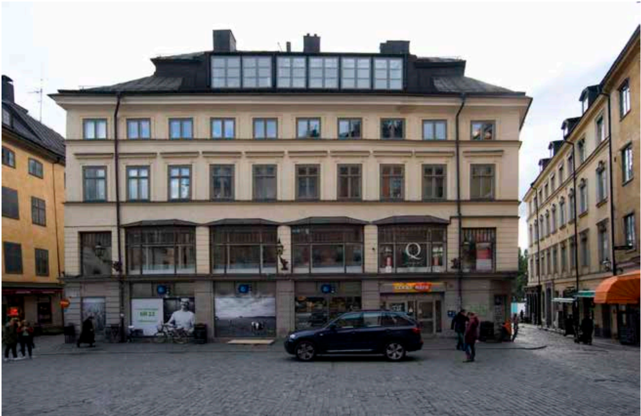
FASADEN VISAR FLERA ÅRHUNDRADENS OMBYGGNADER. SÅTERITAKET TILLKOM UNDER TIDIGT 1700-TAL, VINDENS ATELJÉFÖNSTER 1866 OCH DE BURSPRÅKSLIKNANDE FÖNSTREN PÅ VÅNING 1 TRAPPA 1907, FÖR JULIUS SLÖÖRS JÄRNHANDEL. FOTO: J. MALMBERG.
