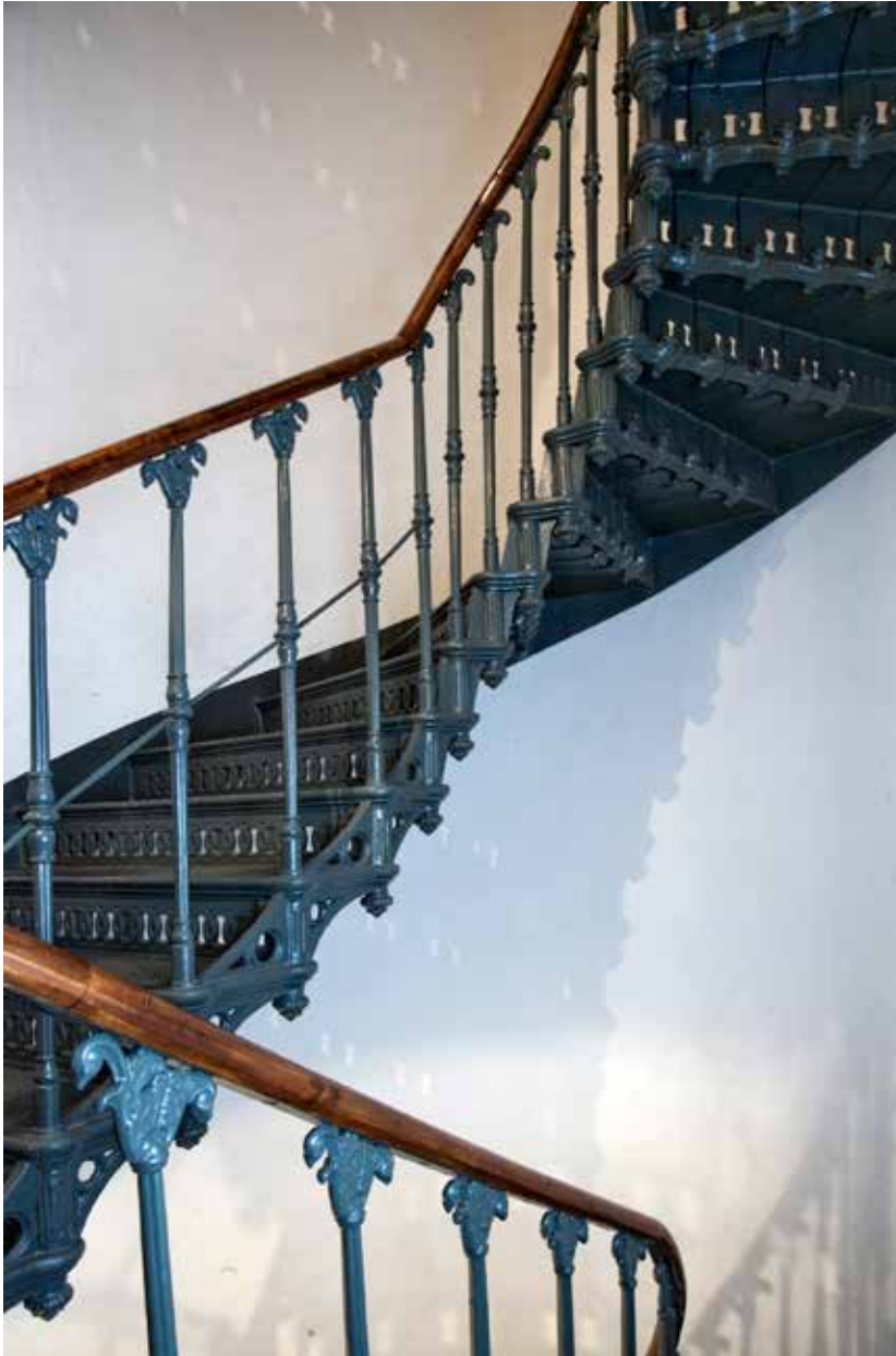
TRAPPAN AV GJUTJÄRN MED DEKORATIVA DETALJER ÄR TYPISK FÖR SIN TID; 1800-TALET'S ANDRA HÄLFT. FOTO: J. MALMBERG.
