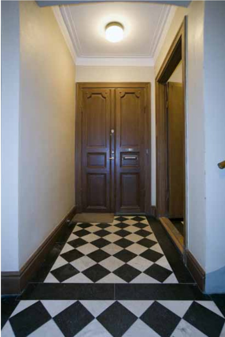
VILPLAN MED GOLV AV MARMOR OCH ÄLDRE PARDÖRRAR. URSPRUNGLIGEN VAR DEN ÖVRE FYLLNINGEN GLASAD. FOTO J MALMBERG
