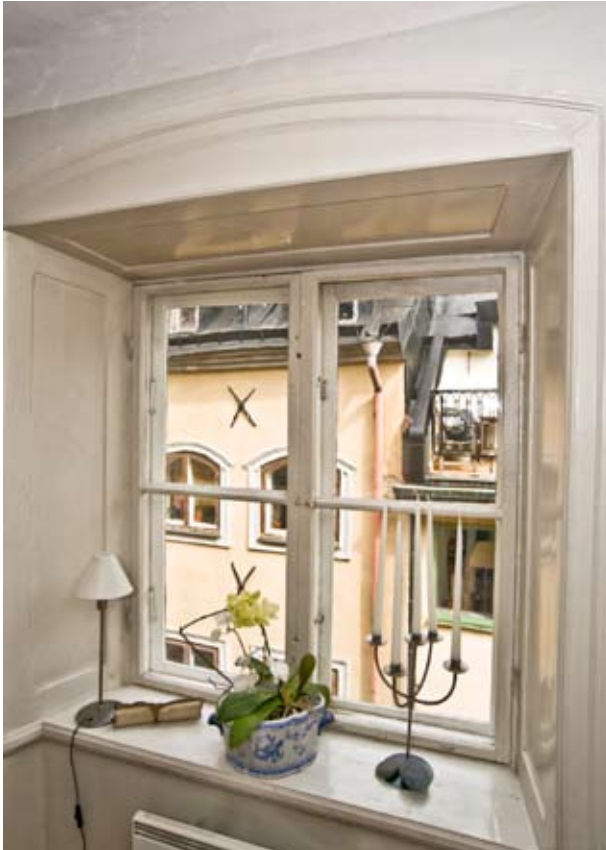
STICKBÄGIG FÖNSTERÖPPNING MED STENPROFILERADE PANELER FRÅN 1800-TALET. FOTO: J. MALMBERG.
