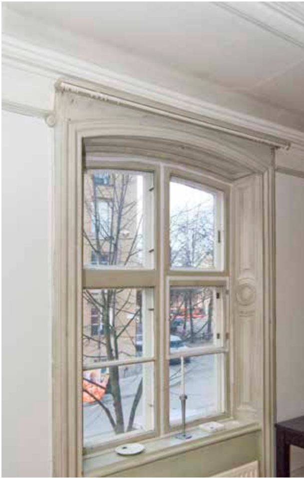
FÖNSTER I HUVUDBYGGNADEN (NR 1) MED URSPRUNGLIGT FODER OCH PANELER, VÅNING 1 TRAPPA. FOTO: J. MALMBERG.
