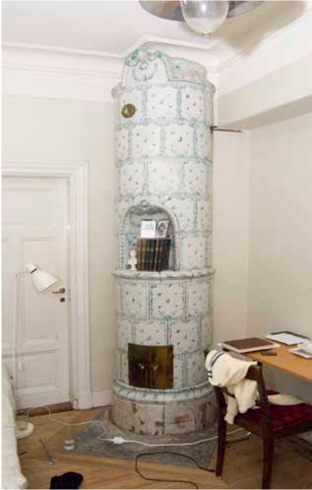
KAKELUGN FRÅN 1700-TALET MITT, HUVUDBYGGNADEN (NR 1), VÅNING 1 TRAPPA. FOTO: J. MALMBERG.
