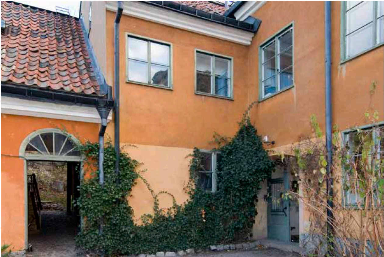
GÄRDSHUSETS (NR 4) FASAD MOT SÖDER. EN SMAL ÖVERBYGGD PORTGÅNG DELAR HUSET I TVÅ DELAR. FOTO: J. MALMBERG.
