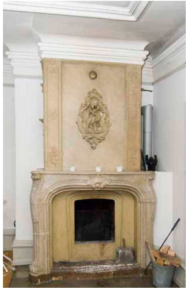
HUS 1. SPISEN I HUVUDBYGGNADENS PARADVÅNING ÄR AV HUGGEN NATURSTEN OCH HAR UTPRÄGLADE ROKOKODRAG. DEN MURADES OM 1816 FRÅN ÖPPEN SPIS TILL KAKELUGN. ÄVEN RUMMETS PROFILERADE TAKLIST ÄR URSPRUNGLIG. FOTO: J. MALMBERG.
