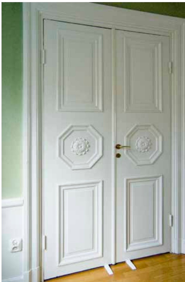
PARDÖRR MED ÅTTKANTIG Fyllning. MALMGÅRDSVÄGEN 57. FOTO: J. MALMBERG.
