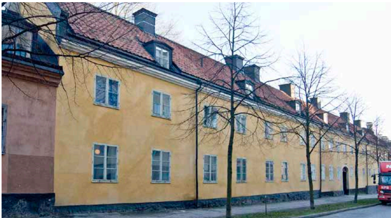
MALMGÅRDSVÄGEN 57, GATUFASADEN SETT MOT SYDÖST. FOTO: J. MALMBERG.
