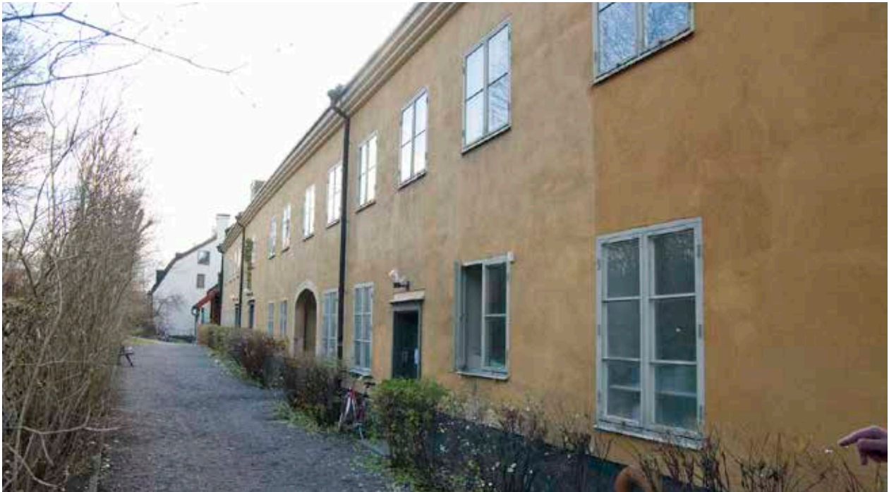
MALMGÅRDSVÄGEN 57, GÅRDEN SETT MOT SYDÖST. FOTO: J. MALMBERG
