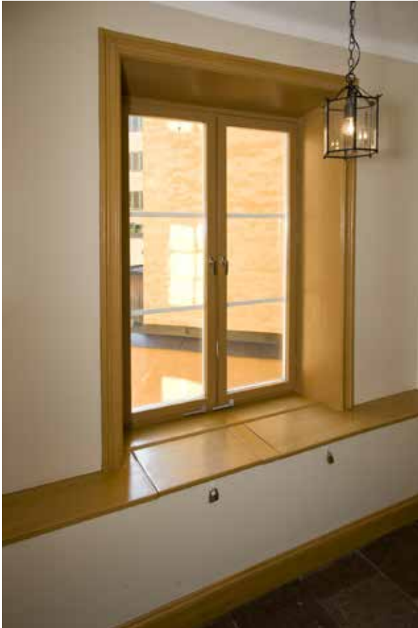
PÅ TRAPPHUSETS VILPLAN FINNS URSPRUNGLIG VEDLÅR BEVARAD. FOTO: J. MALMBERG
