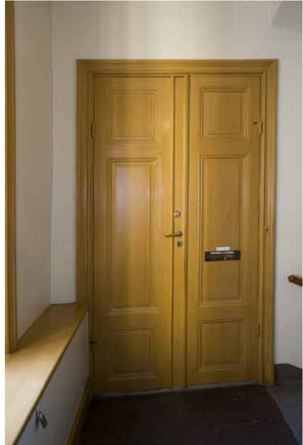
I TRAPPHUSET FINNS URSPRUNGLIGA LÄGENHETSDÖRRAR MED TRE HALVFRANSKA FYLLNINGAR. FOTO: J. MALMBERG
