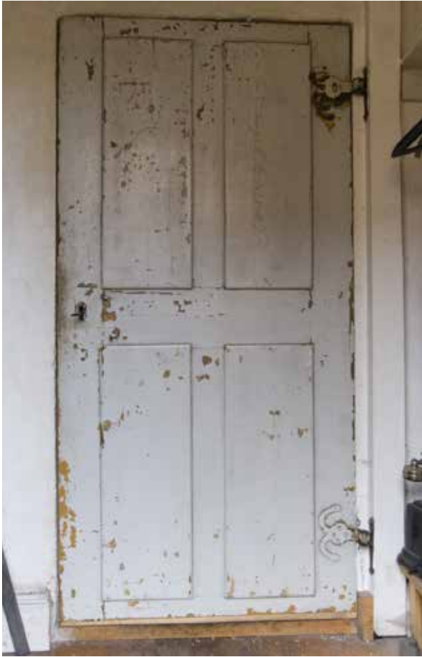
ÄLDRE DÖRR MED FYRA UTANPÅLIGGANDE FYLNINGAR OCH DEKORATIVA GÅNGJÄRN. FOTO J. MALMBERG.
