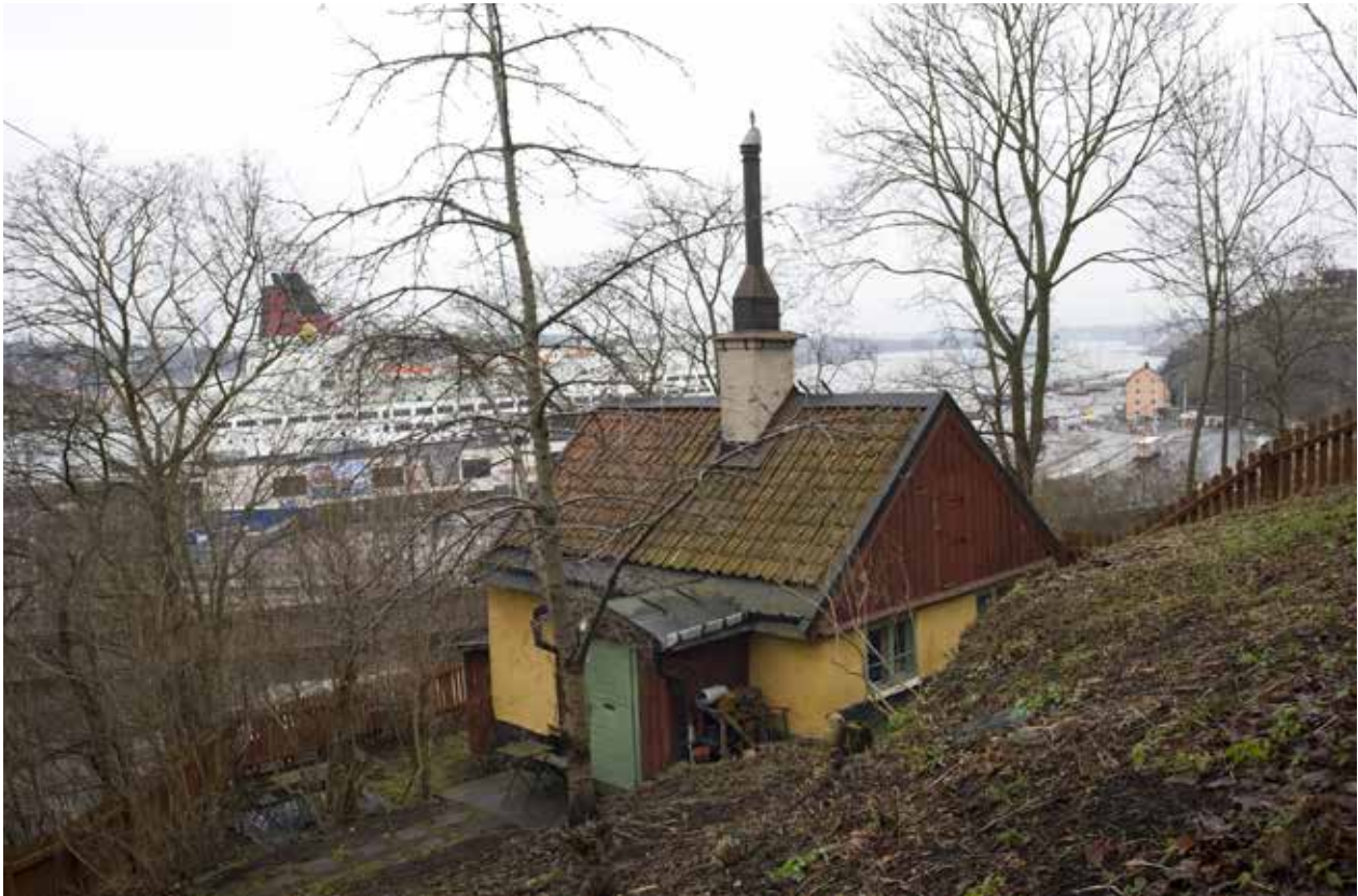
HUSET ÄR UPPFÖRT PÅ EN KUPERAD TOMT. VY MOT NORR. FOTO J. MALMBERG.
