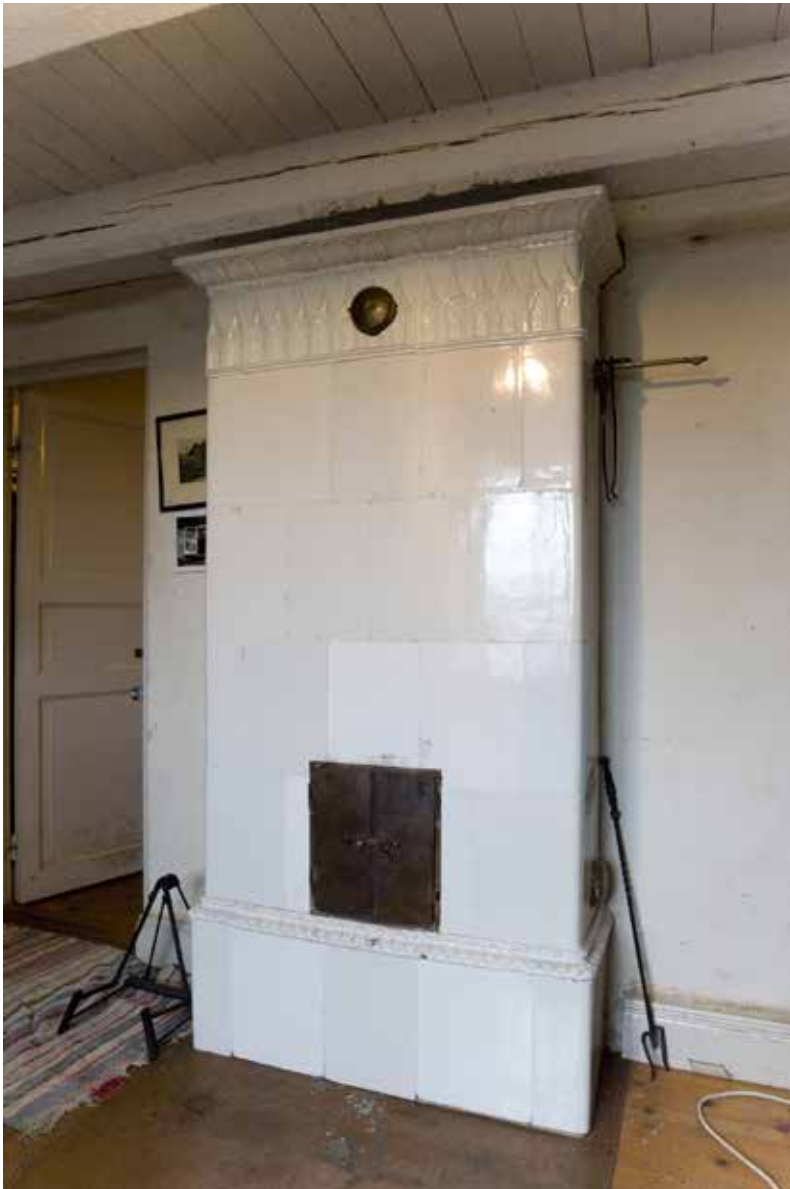
KAKELUGN FRÅN MITTEN AV 1800-TALET SAMT BJÄLKAR I TAK. FOTO J. MALMBERG.
