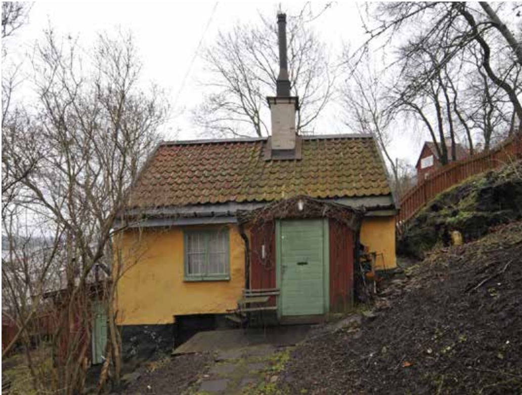
BYGGNADEN MED DEN PANELADE FARSTU- KVIISTEN MOT ÖSTER. FOTO J. MALMBERG.
