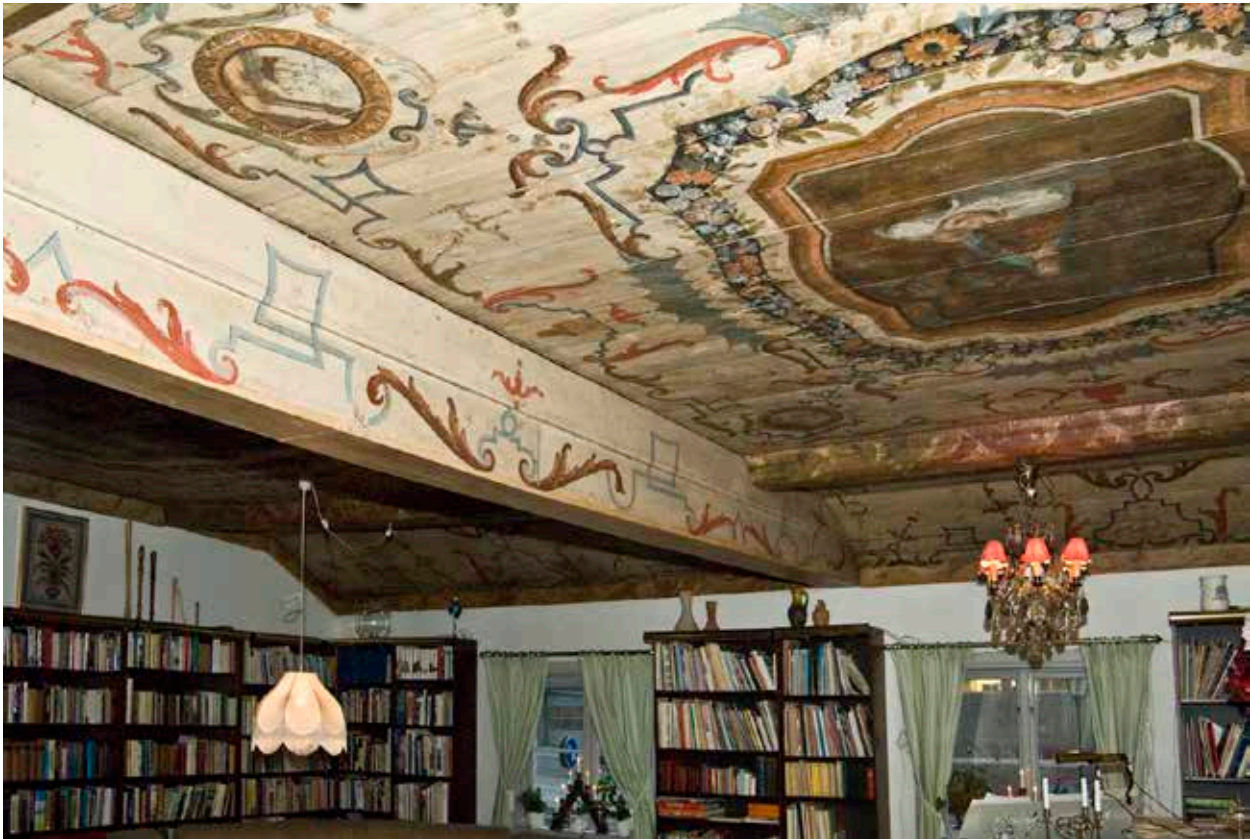
DET MÅLADE TAKET I BOSTADSHUSET INOM UTKIKEN 19 ÄR FRÅN 1700-TALET'S FÖRRA HÄLFT. FOTO: J. MALMBERG.
