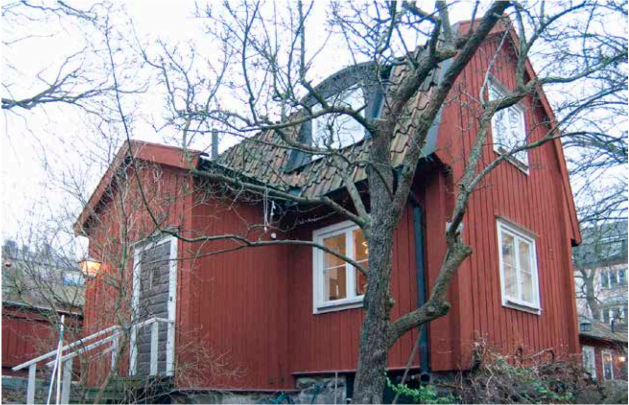
UTKIKEN 10 MED ENTRÉ GENOM EN TILLBYGGNAD FRÅN 1960-TALET. FOTO: J. MALMBERG.
