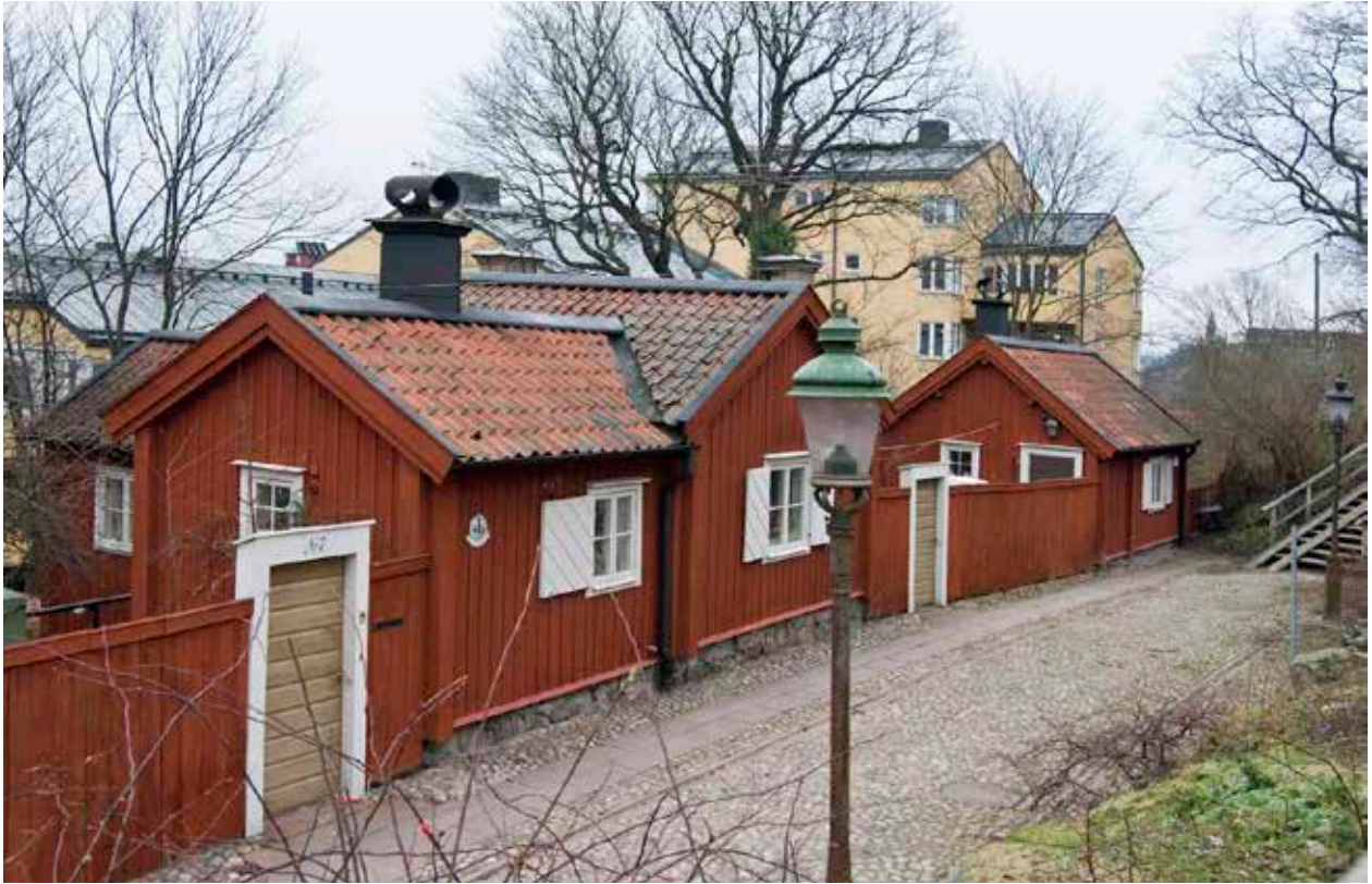
BYGGNADERNA INOM UTKIKEN 22 SETT LÄNGS LOTSOGATAN MOT ÖSTER. FOTO: J. MALMBERG.
