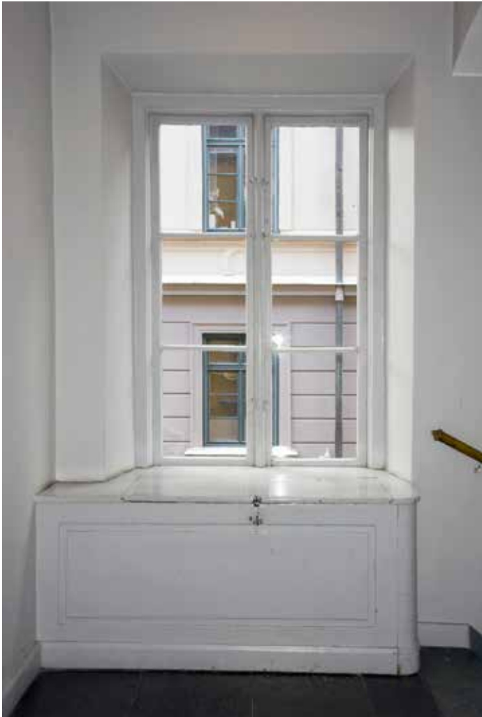
I TRAPPHUSET FINNS URSPRUNGLIGA FÖNSTER OCH VEDLÅR. FOTO: J. MALMBERG
