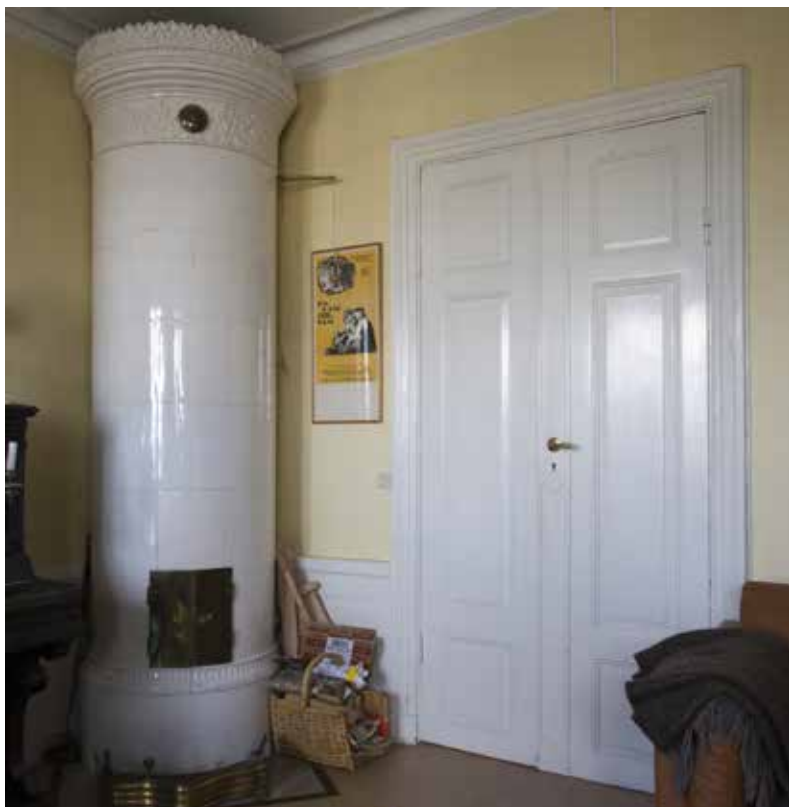
I LÄGENHETERNA FINNS BEVARADE RUNDA, VITA KAKELUGNAR, BRÖSTPANELER, TAKFRISER OCH PARDÖRRAR MED TRE HALVFRANSKA Fyllningar. FOTO: J. MALMBERG
