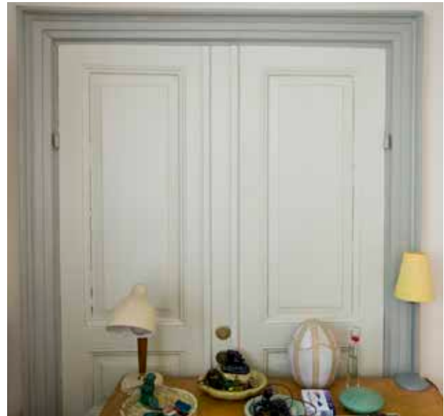
PARDÖRRAR FRÅN SENT 1800-TAL MED DÖRRFODER FRÅN TIDIGT 1800-TAL. FOTO: J. MALMBERG.
