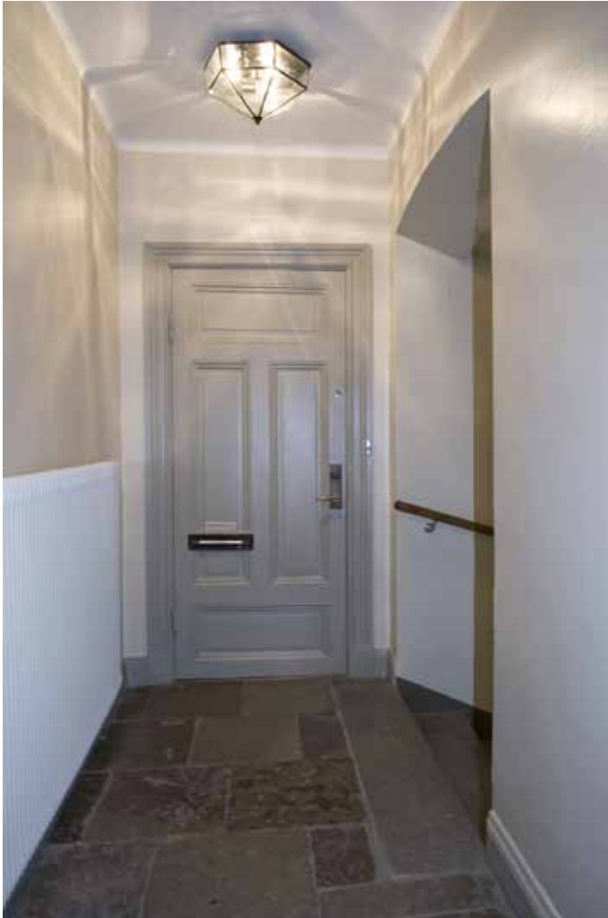
I Huset som uppfördes under 1800-talet bevarar trapphuset kalkstensgolv, trappa och fyllningsdörrar. FOTO: J. MALMBERG
