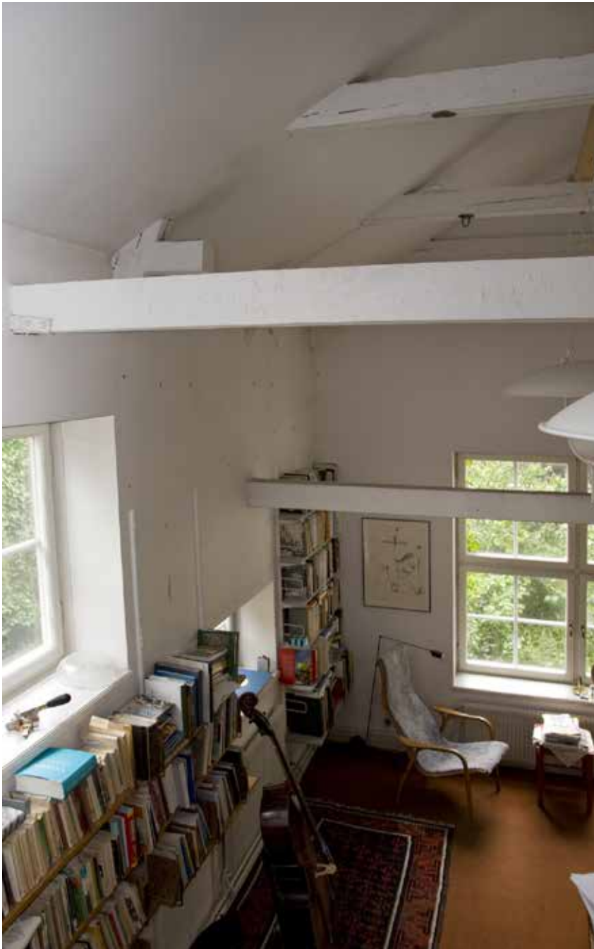
I DET FÖRE DETTA UTHUSET VID DEN NORRA TOMTLINJEN INREDDES EN ATELJÉ UNDER 1970-TALET MED SYNLIGA TAKBJÄLKAR. FOTO: J. MALMBERG
