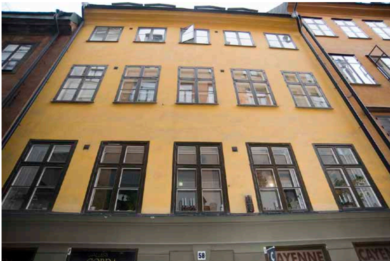
FASADEN MOT VÄSTERLÅNGGATAN BEVARAR MYCKET AV 1700-TALET'S KARAKTÄR MED SLÄTPUTSADE FASADER, FÖNSTER I MURLIVET OCH VISSA BEVARADE FÖNSTERBÅGAR OCH - KARMAR. FOTO: J. MALMBERG.
