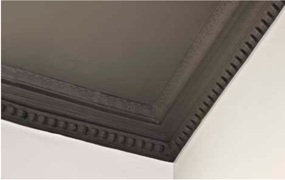
TAKLISTEN I ENTRÉPORTEN FRÅN ÖSTERLÅNGGATAN ÄR BEVARAD SEDAN UPPFÖRANDET. FOTO: J. MALMBERG.
