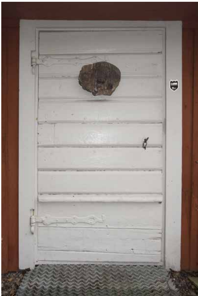
ÄLDRE BRÄDDÖRR TILL GÅRDSHUSET MED BANDGÅNGJÄRN AV 1600-TALSTYP. FOTO. J. MALMBERG.
