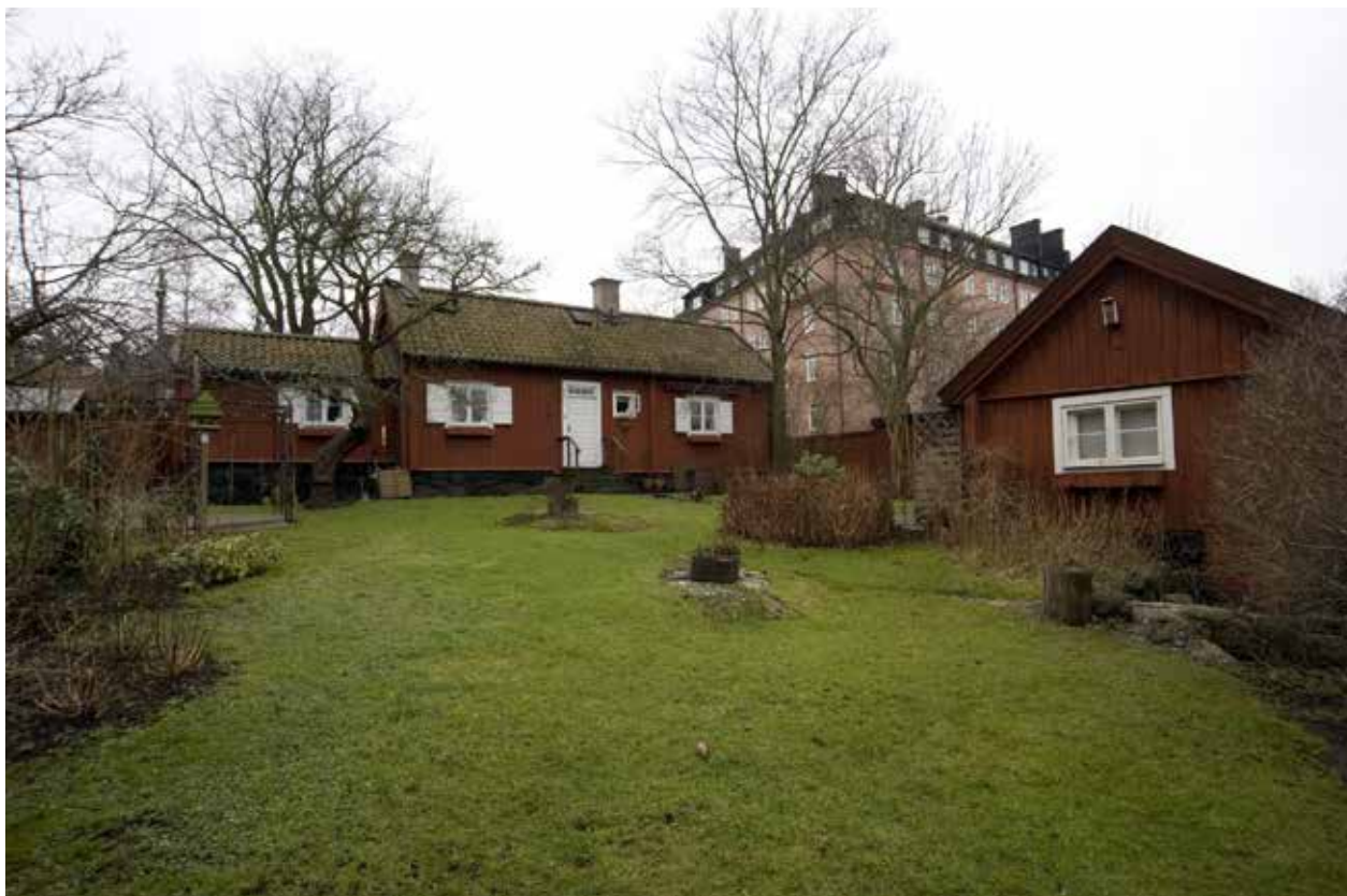
VY FRÅN NORR ÖVER GATHUSETS NORRA FASAD OCH GÅRDSHUS. FOTO. J. MALMBERG.
