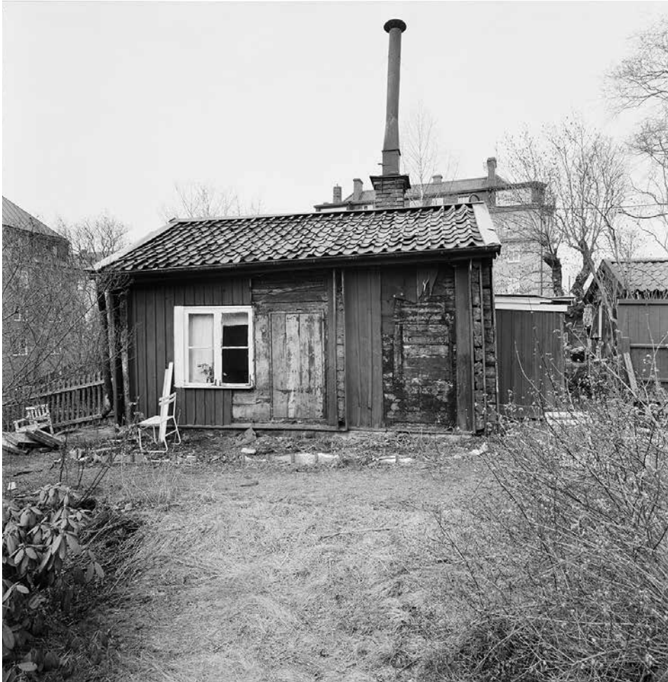
HUSET MED DELVIS BORTTAGEN YTTERPANEL 1998. HÄR SYNS EN ÄLDRE IGENSATT DÖRR TILL KAMMAREN OCH ETT FÖNSTER TILL KÖKET. FOTO I. JOHANSSON, SSM 598-0149-2.
