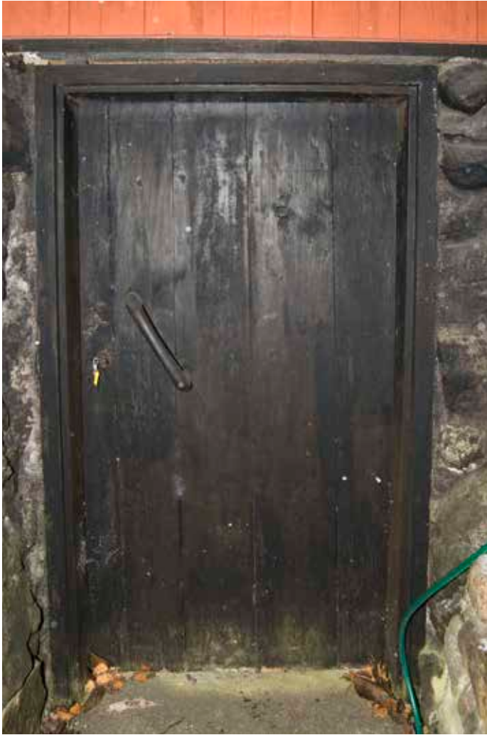
KÄLLARDÖRR TILL FASTIGHETEN TJÄRHOVET STÖRRE 39 MED HANDHYVLAD PANEL. FOTO: J. MALMBERG.
