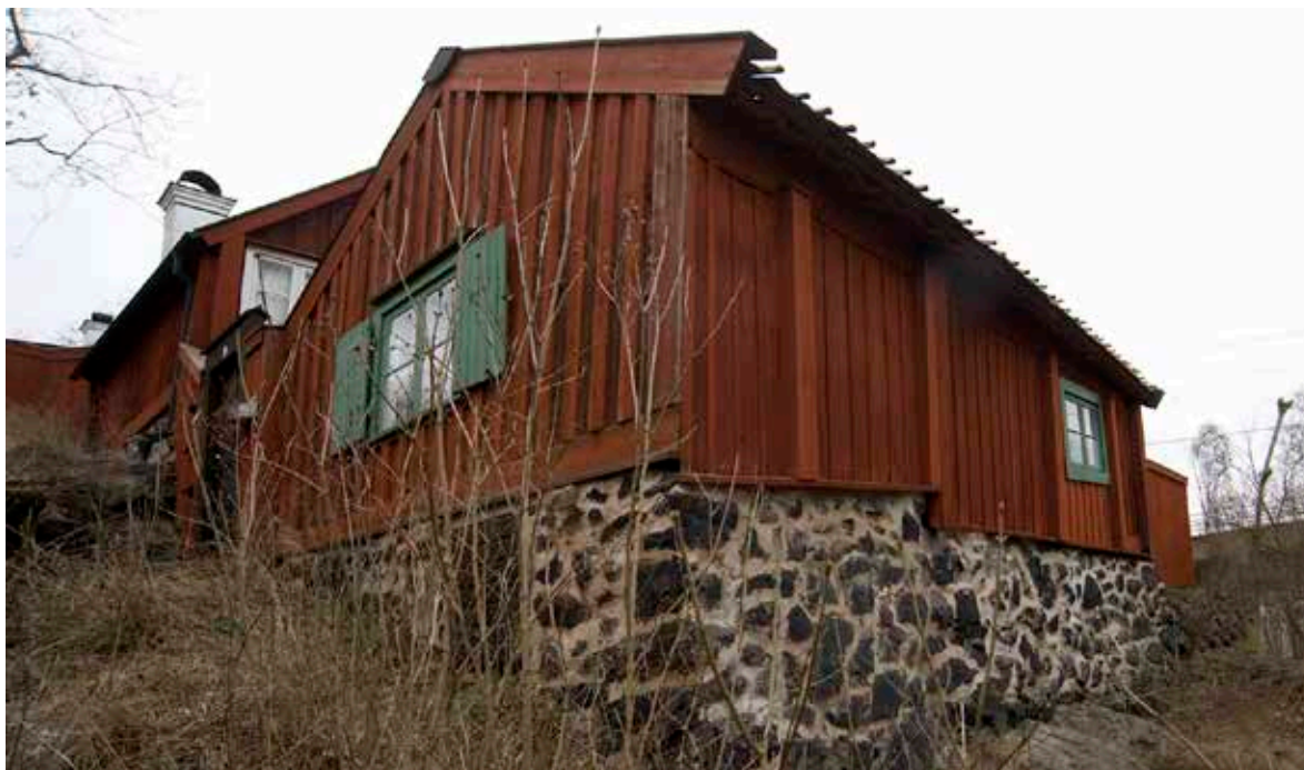
BAKSIDAN PÅ HUSET VID KVAFTMAKARTRAPPAN 2 MED HÖG GRÄSTENSGRUND. FOTO J. MALMBERG.
