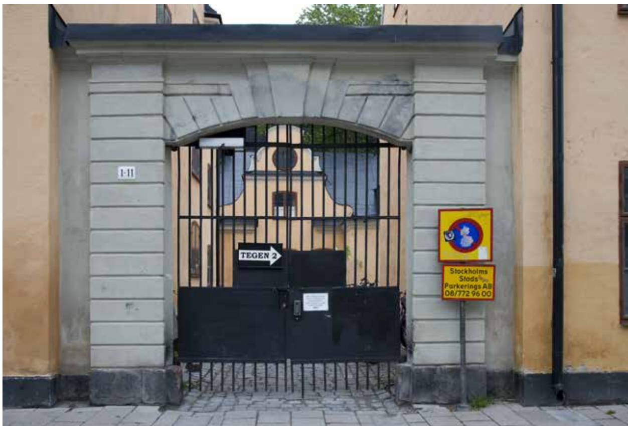
FASTIGHETENS HUVUDPORT MOT BJURHOLMSGATAN SOM SANNOLIKT ÄR FRÅN 1760-TALET. FOTO: J. MALMBERG.
