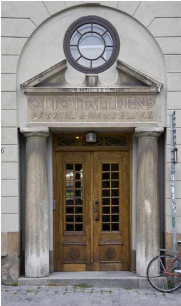
URSPRUNGLIG 1700-TALS PORTAL SOM BYGGDES PÅ UNDER 1920-TALET OCH FICK EN NYKlassicistisk PRÄGEL MED DORISKA PELARE OCH PARDÖRR. FOTO: J. MALMBERG
