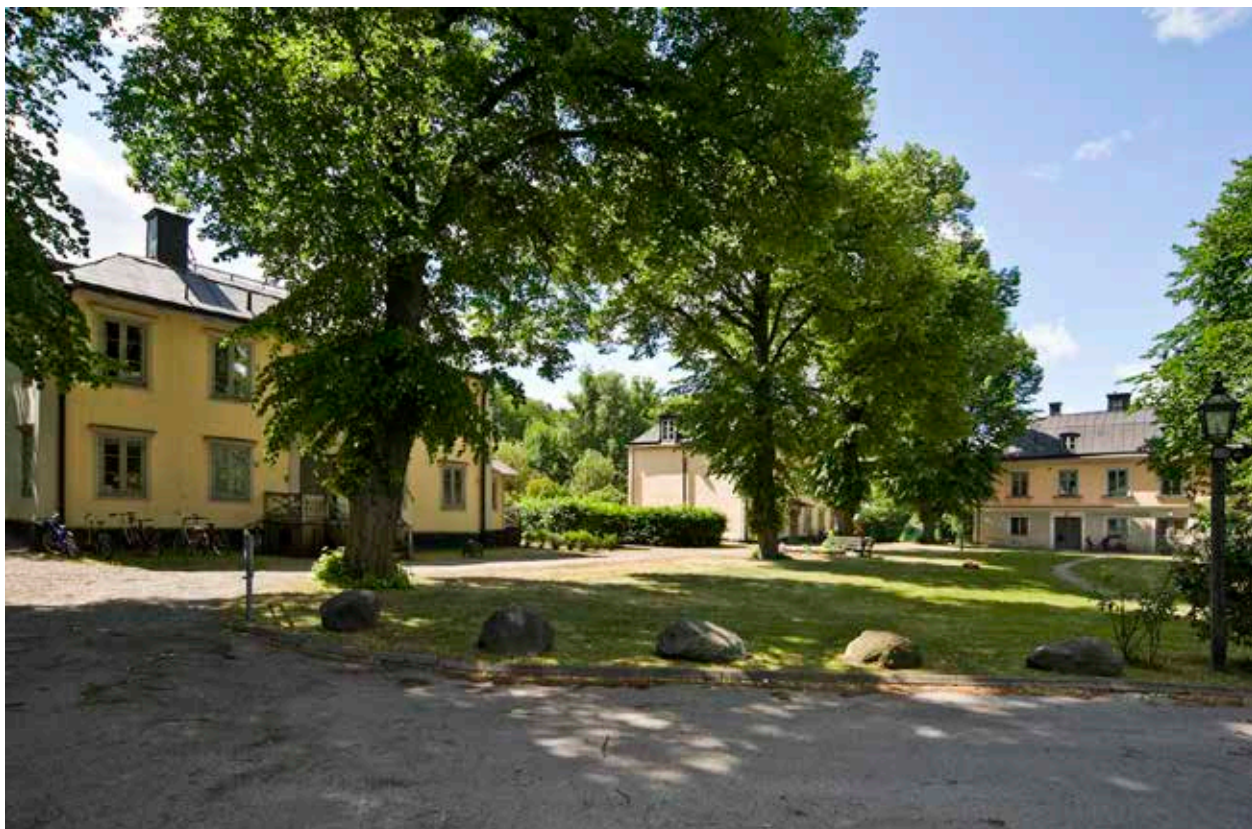
HUVUDBYGGNADEN (NR 1) TILL VÄNSTER, DET FÖRE DETTA SÅPSJUDERIET (NR 2) I MITTEN OCH STENHUSET (NR 3) TILL HÖGER. FOTO: J. MALMBERG.
