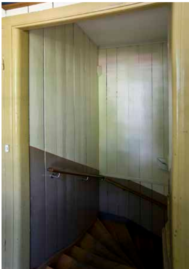
TRAPPA AV TRÄ, HUVUDBYGGNADEN (NR 1). FOTO: J. MALMBERG.
