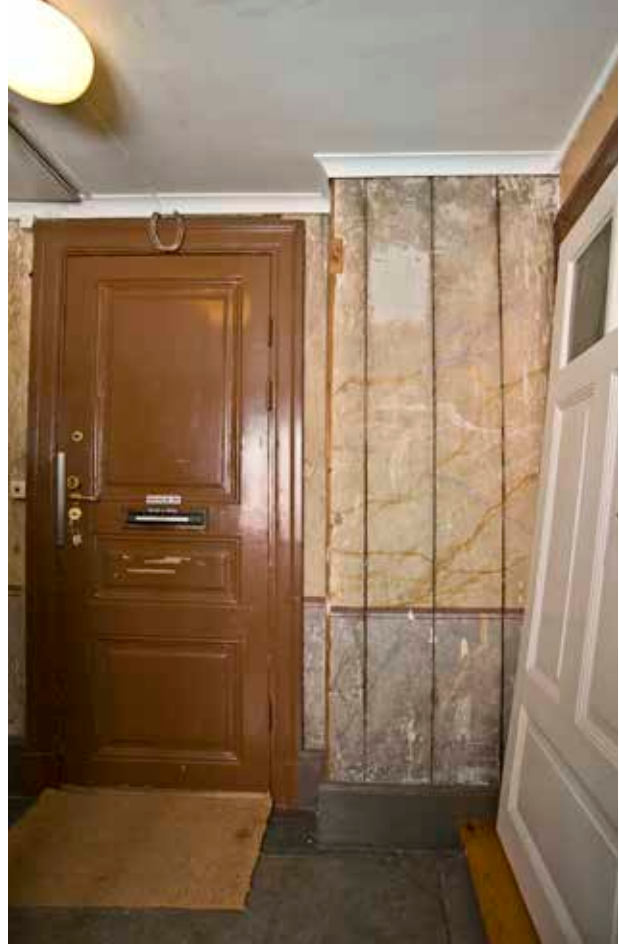
TRAPPHuset MED ÅDRINGSMÅLADE VÄGGAR OCH HALVFRANSK ENKELDÖRR I HÖRNHuset ÖSTGÖTAGATAN/KAPELLGRÄND. FOTO J. MALMBERG.
