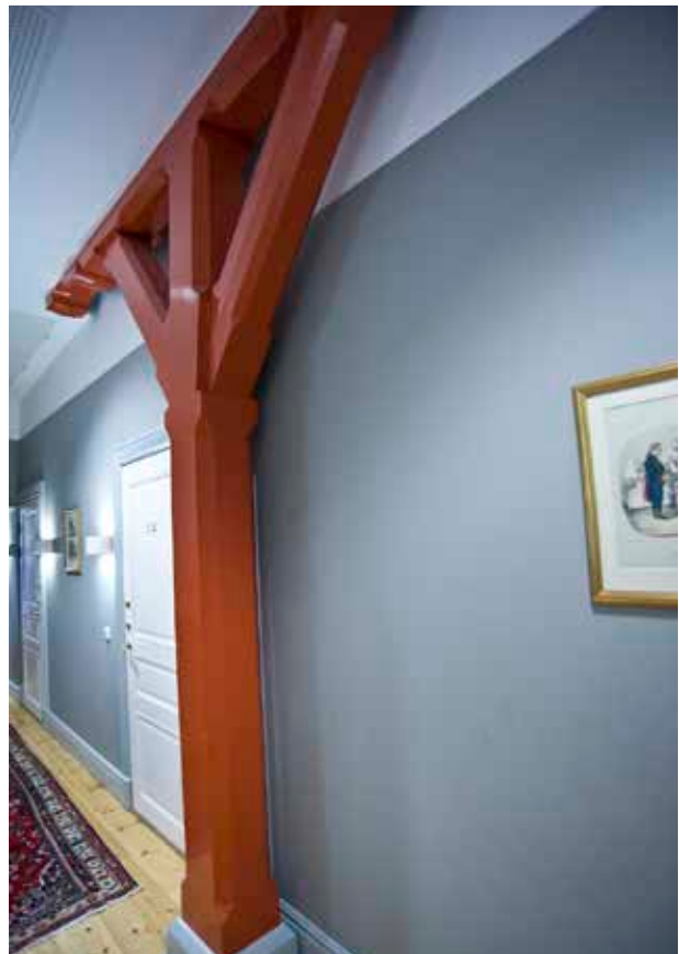
BILD TILL HÖGER: ÄLDRE BÄRANDE KONSTRUKTION AV TRÄ I HOTELLDELEN. FOTO J. MALMBERG.
