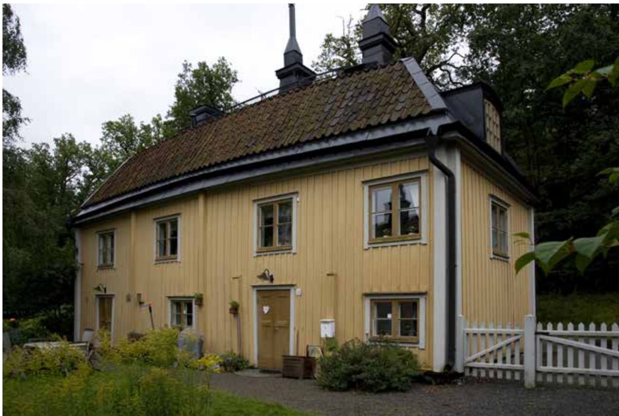
DET SÖDRA BOSTADSHUSET. FOTO: J. MALMBERG.
