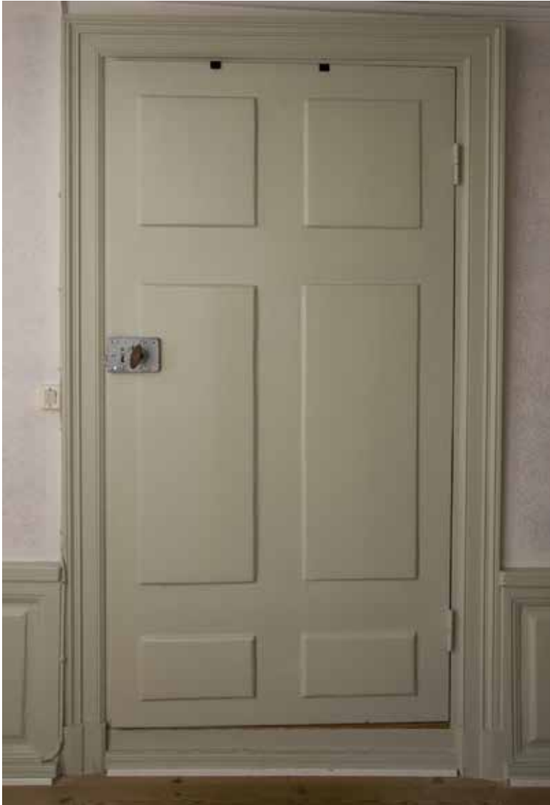
ÄLDRE DÖRR MED SEX UTANPÅLIGGANDE Fyllningar, SANNOLIKT SEKUNDÄRT FLYTTAD TILL Huset. FOTO: J. MALMBERG
