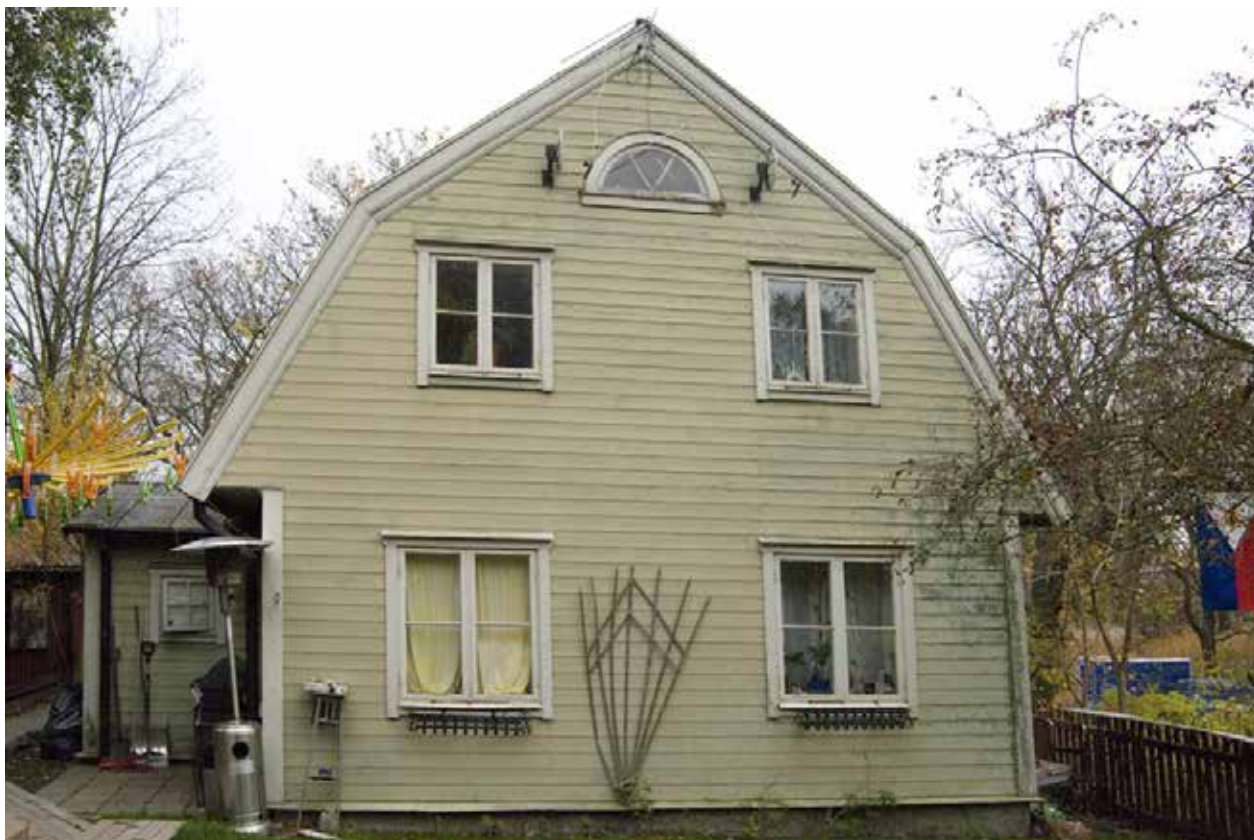
HUS 1 PÅ KARTAN SETT FRÅN VÄSTER. TILL VÄNSTER SKYMTAR HUS 2. FOTO: J. MALMBERG.
