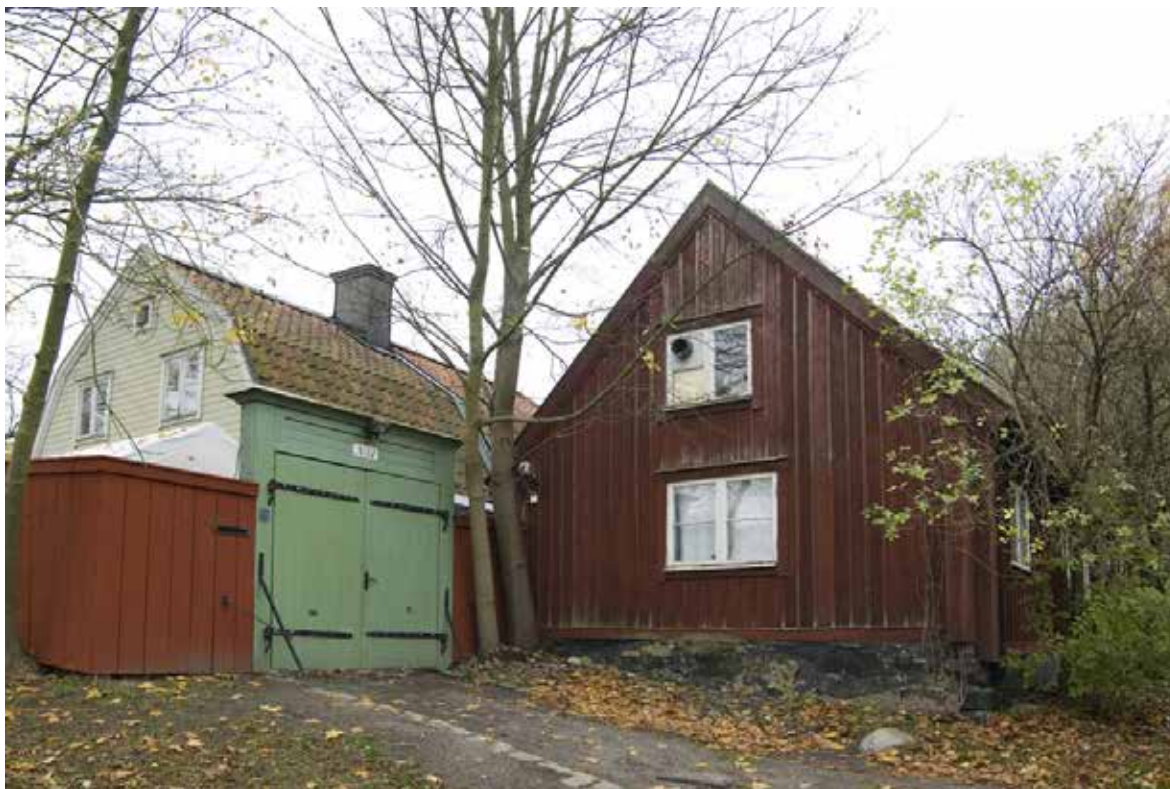
HUS 1 OCH 2 FRÅN ÖSTER OCH STORA MEJTENS GRÄND. FOTO: J. MALMBERG.
