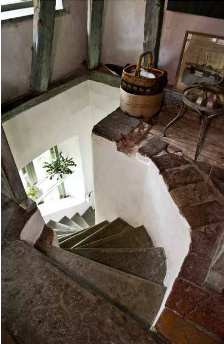
URSPRUNGLIG KALKSTENSTRAPPA MED S- FORM, FJÄLLGATAN 29. FOTO: J. MALMBERG.
