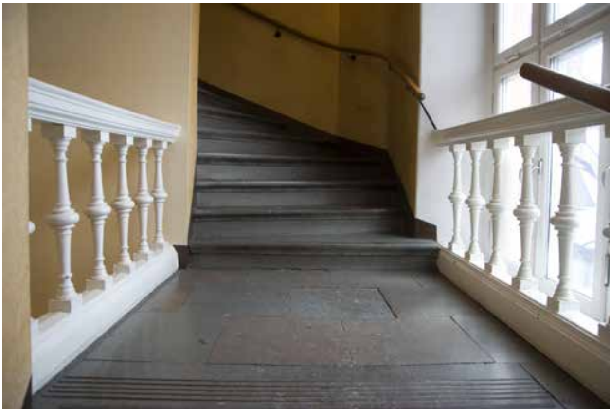
TRAPPHUSET TILL FJÄLLGATAN 23B MED KALKSTEN OCH RÄCKEN AV SVARVADE BALUSTERDOCKOR FRÅN BYGGNADSTIDEN. FOTO J. MALMBERG.
