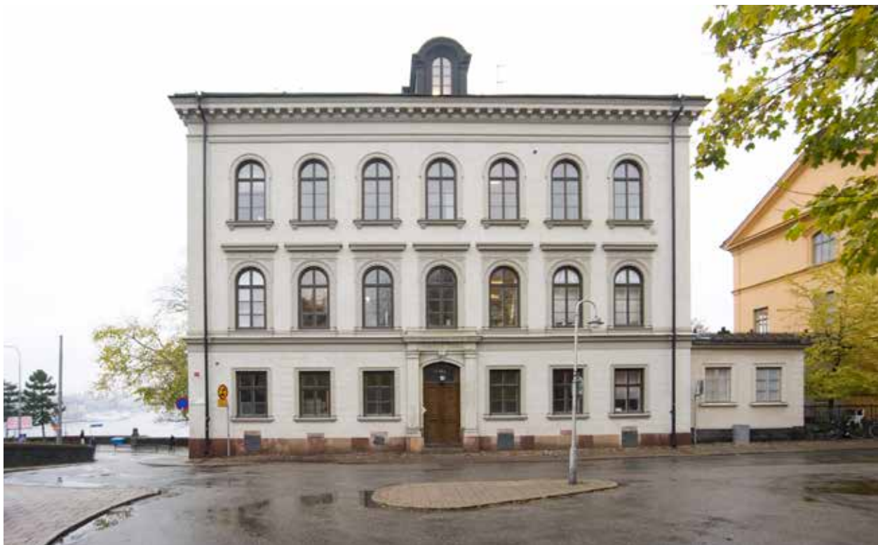
DEN ÄLDSTA BYGGNADENS FASAD MOT FJÄLLGATAN. ÖVERSTA VÅNINGEN OCH FÖNSTEROMFATTNINGARNA PÅ VÅNING 1 TRAPPA KOM TILL VID SEKELSKIFTET 1900. FOTO J. MALMBERG.
