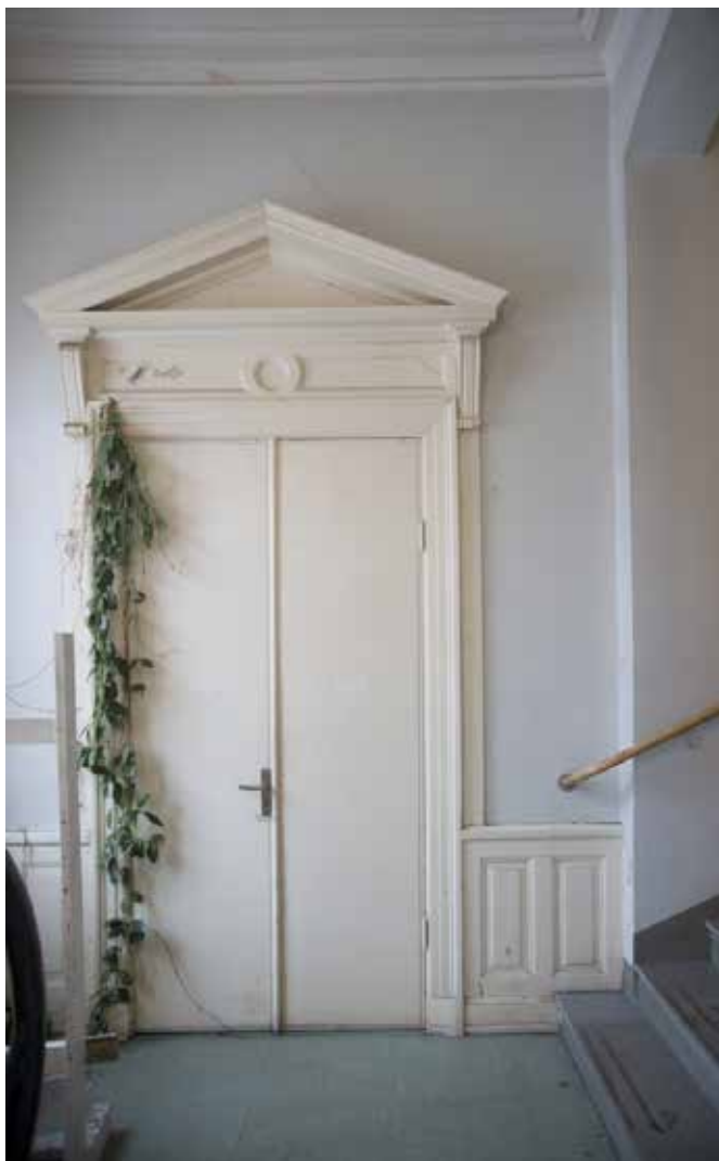
HÖGREST DÖRR MED SPETSIGT OCH DEKORERAT ÖVERSTYCKE I TRAPPHUSET TILL FJÄLLGATAN 23A. DÖRRBLADEN HAR SENARE TÄCKTS MED SLÄTA, SEKUNDÄRA SKIVOR. FOTO J. MALMBERG.
