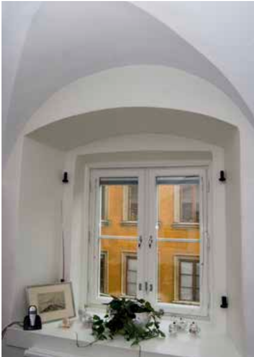
DJUP FÖNSTERSMYG MED KRAFTIGA GÅNGJÄRN TILL ÄLDRE FÖNSTERLUCKOR AV JÄRNPLÅT. FOTO J. MALMBERG.
