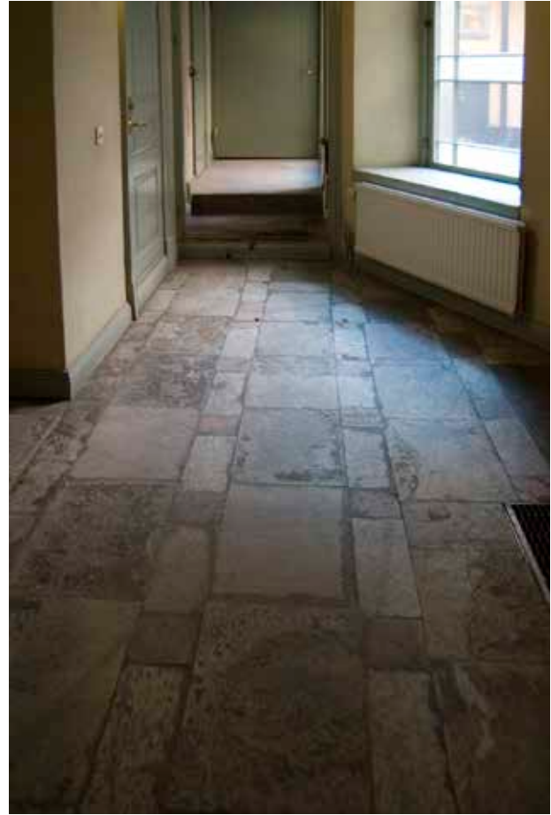
TRAPPHUS MED ÄLDRE KALKSTENSGOLV. FOTO J. MALMBERG.
