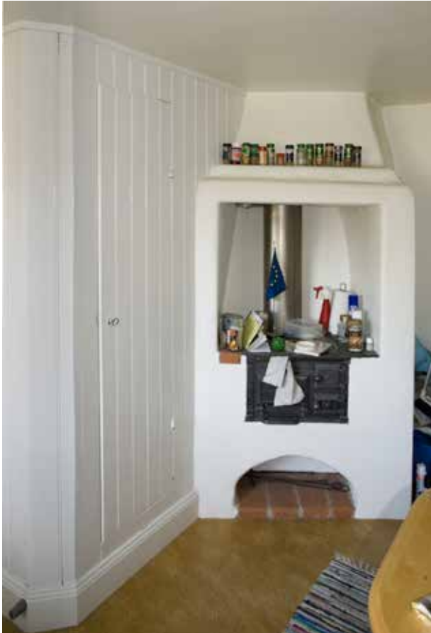
I STIGBERGSGATAN 17 FINNS BEVARAD MURAD SPIS FRÅN 1700-TALET SAMT PÄRLSPONTSPANEL. FOTO: J. MALMBERG
