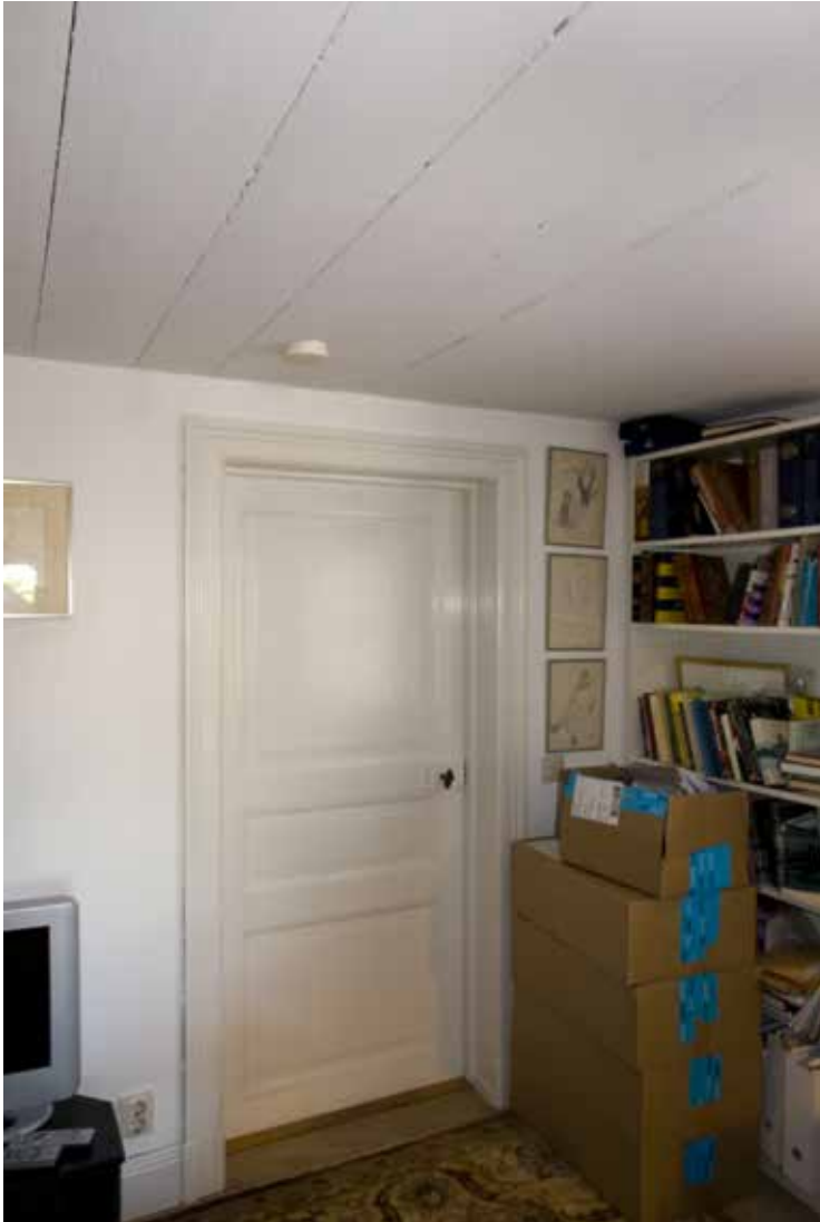
HALVFRANSK TREFYLLNINGSDÖRR MED KAMMARLÅS SAMT ÄLDRE BRÅDTAK. FOTO: J. MALMBERG
