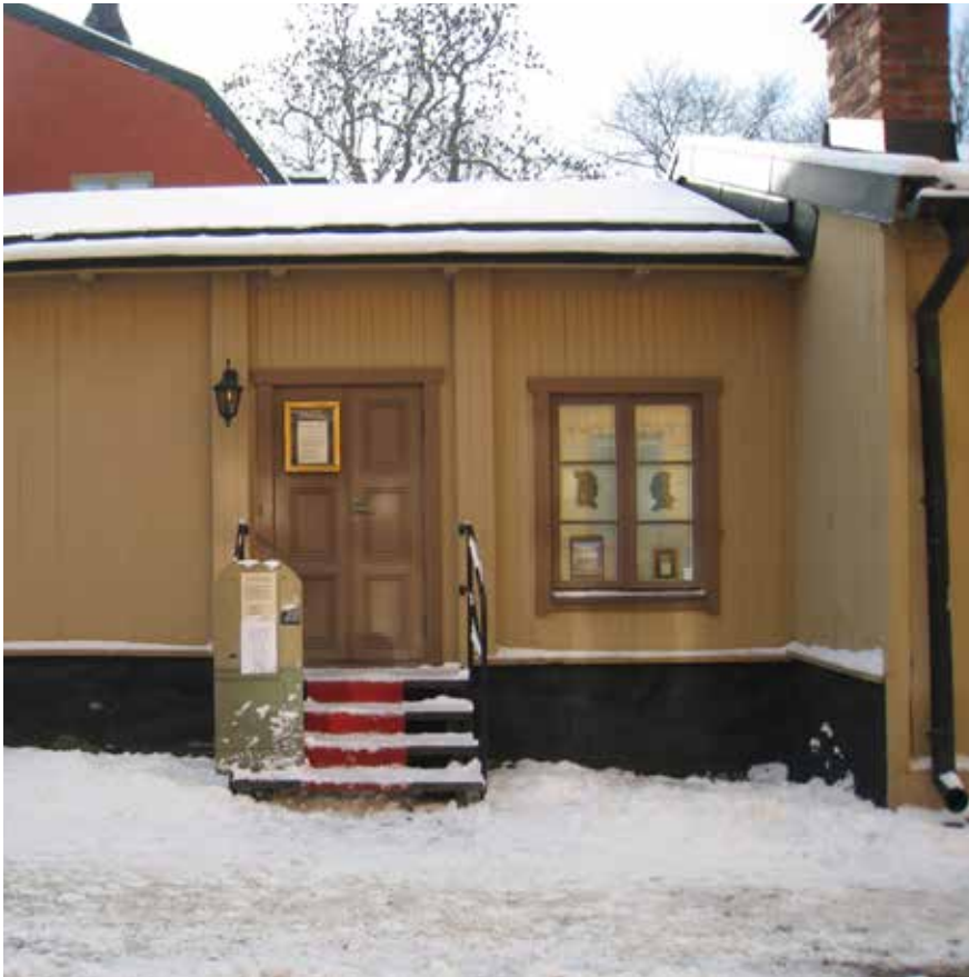
DEL AV DET ÄLDSTA TRÄHUSETS FASAD MOT FJÄLLGATAN. FOTO H. SCHÖNBÄCK.
