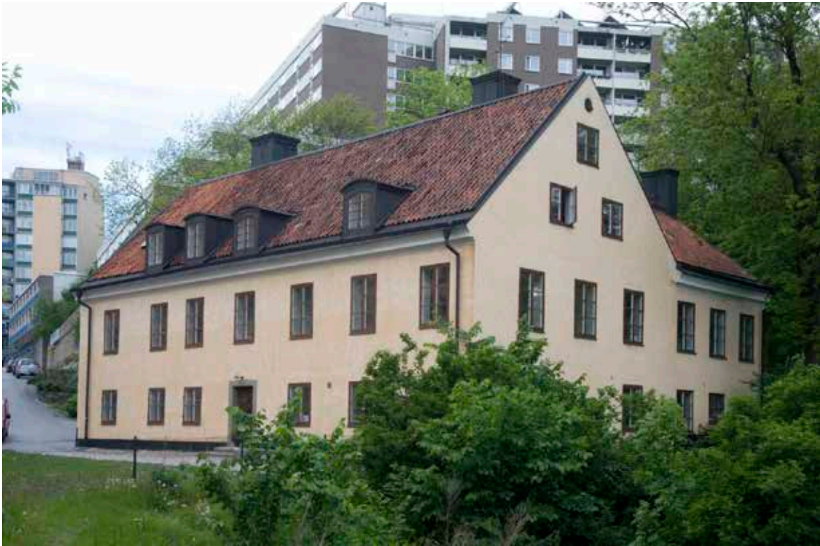
STORA STENHUSETS FASAD MOT FOLKUNGAGATAN. T.H. SKYMTAR DEN LILLA TILLBYGGDA FLYGELN FRÅN 1875 MED SINA TRE FÖNSTERAXLAR. FOTO J. MALMBERG.
