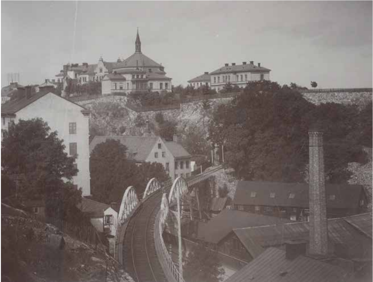
STADSVARVETS KONTORSBYGGNAD LITE UNDANGÖMD NEDANFÖR BERGSKANTEN VID ERSTA. TILL HÖGER OM SALTSJÖBANANS BRO LIGGER SKJUL OCH MAGASIN SOM TILLHÖRDE SJÄLVA VARVSVERKSAMHETEN. HÄR DROGS 1907 FOLKUNGAGATAN FRAM FÖR ATT SKAPA FÖRBINDELSE MED STADSGÅRDEN. FOTO U.Å. SSM F41401.
