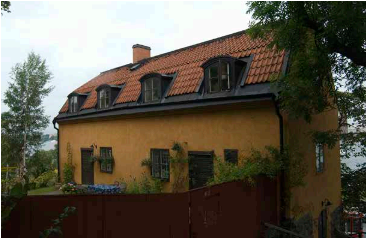
VÄSTRA HUSET, DEN F.D. VERKSTADEN, FASADEN MOT SÖDER. FOTO J. MALMBERG.
