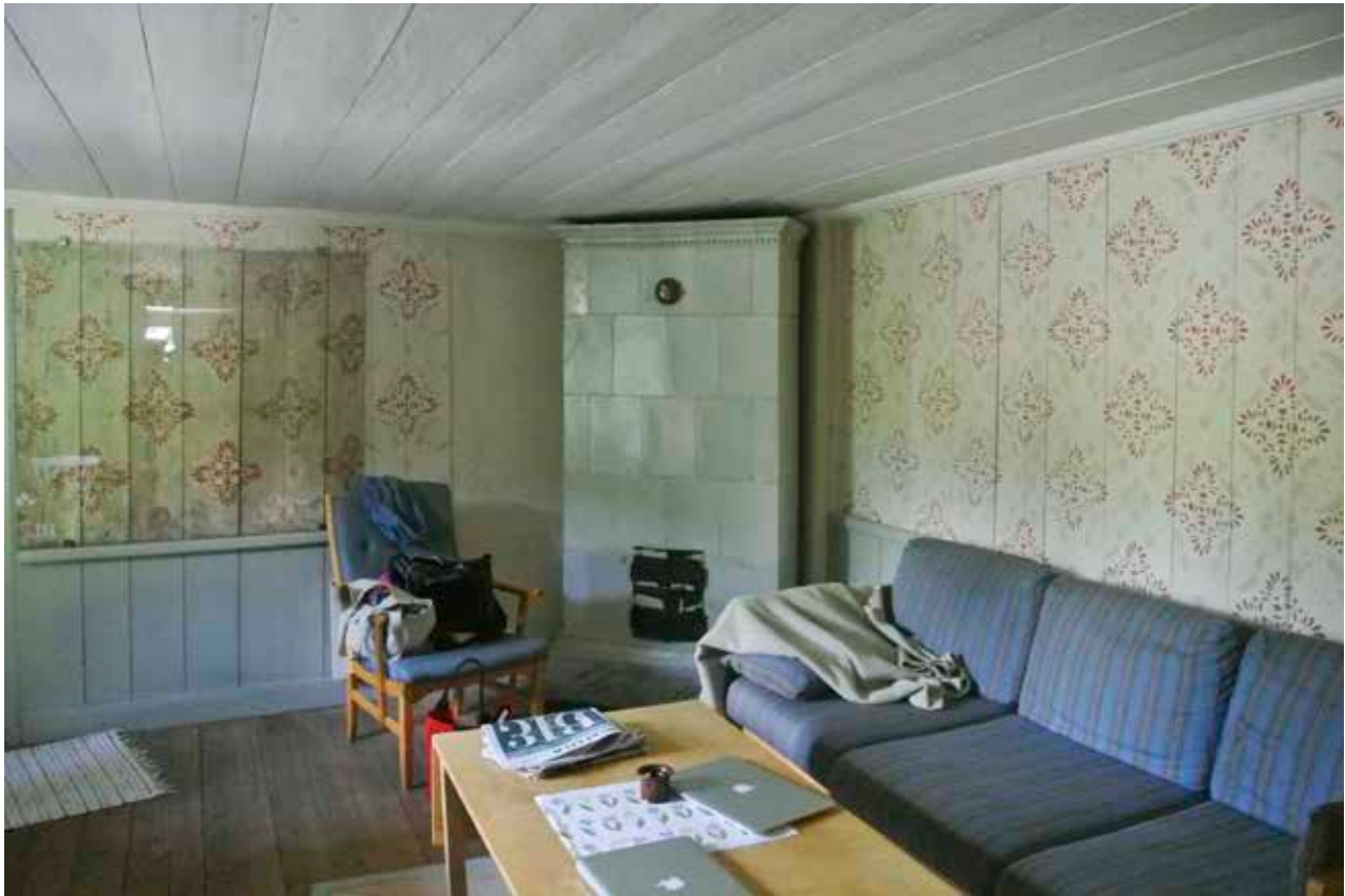
DET VÄSTRA HUSETS STORA RUM MED KAKELUGN FRÅN 1800-TALET S FÖRRA HÄLFT, BRÖSTPANEL OCH SCHABLONMÅLERI PÅ VÄGGARNA. BAKOM GLASET ÄR DEN URSPRUNGLIGA MÅLNINGEN BEVARAD, PÅ ÖVRIGA YTOR ÄR DEN REKONSTRUERAD. FOTO: J. MALMBERG.
