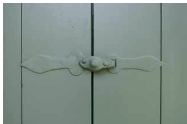
DETALJ AV LUCKORNA TILL FÖNSTERÖPPNINGEN MOT GÅRDEN PÅ DET ÖSTRA HUSET. FÖNSTRET HAR FUNNITS DÄR SEDAN UPPFÖRANDET PÅ 1700-TALET. FOTO: J. MALMBERG.
