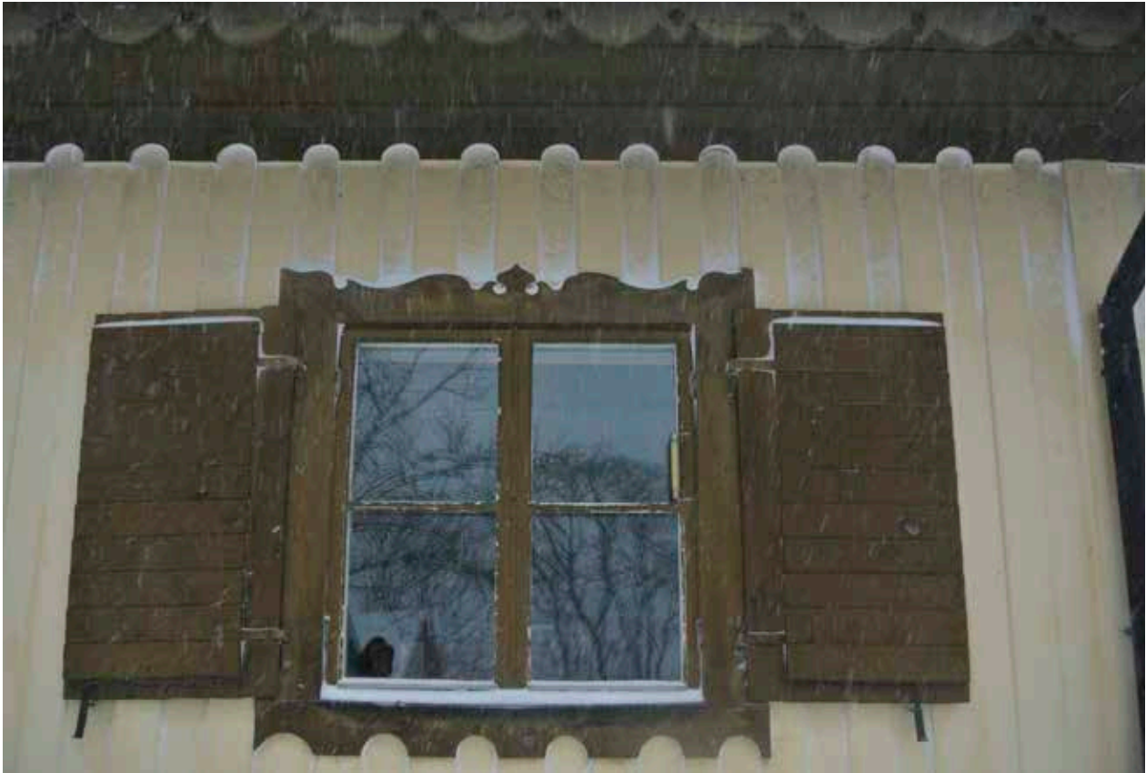
DE SPRÖJSADE FÖNSTREN OMFATTAS AV SLÄTA, FIGURSÅGADE FODER OCH KAN TILLSLUTAS MED FÖNSTERLUCKOR. FASADENS PANEL AVSLUTAS UPPÅT GENOM EN LIGGANDE BRÄDA SOM ÄR FIGURSÅGAD I BÅGAR. ÖVERST I BILD SKYMTAR DEN LIKALEDES FIGURSÅGADE TAKFOTSLISTEN. FOTO J. MALMBERG.
