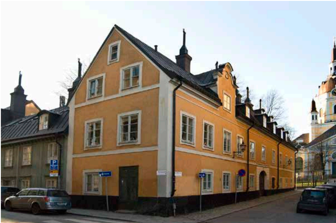
KVARTERET FRÅN HÖRNET NYTORGSGATAN-MÄSTER MIKAELS GATA. FASADEN HAR EN SIRLIGT UTFORMAD PRYDNADSGAVEL OCH SLÅTA FÖNSTEROMFATTNINGAR, MARKERADE HÖRN OCH VÄNINGSBAND. FOTO J. MALMBERG.
