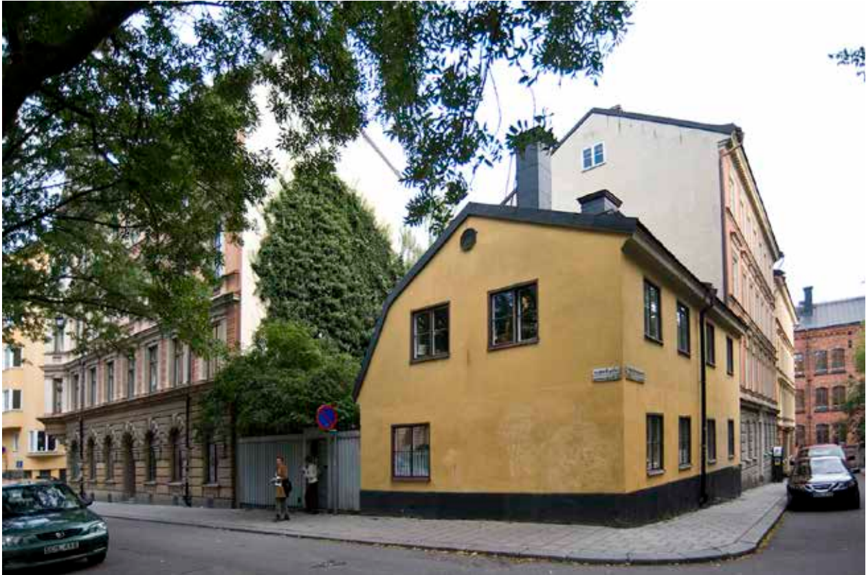
STENHUSET FRÅN OMKRING 1830 MED BRUTET TAK MOT GÅRDEN OCH ENKELT TAKFALL MOT GATAN. FOTO J. MALMBERG.
