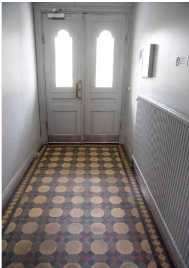
PORTGÅNGEN MED ETT FLERFÄRGAT "ENGELSKT PORSLINSGOLV". FOTO J. MALMBERG.
