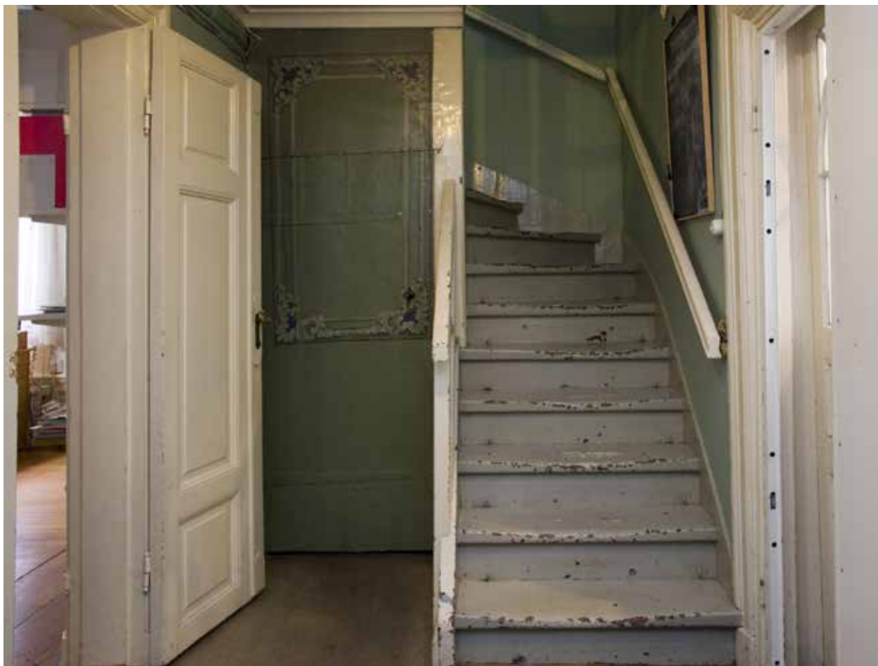
I DET VÄSTRA GATHUSETS FÖRSTUGA FINNS EN ÄLDRE BEMÅLAD DÖRR, HALVFRANSKA PARDÖRRAR SAMT TRÄTRAPPA TILL VINDSVÅNINGEN. FOTO: J. MALMBERG
