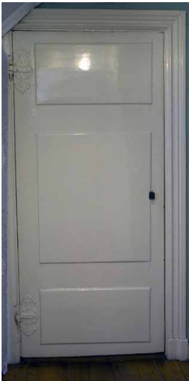
DÖRR MED PLATTA GÅNGJÄRNSBESLAG OCH UTANPÅLIGGANDE Fyllningar från 1700-talet. FOTO: J. MALMBERG
