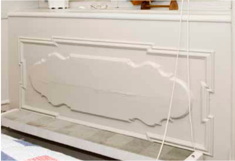
FÖNSTERBRÖSTPANEL, 1700-TAL, PYGMALION 5. FOTO: J. MALMBERG.
