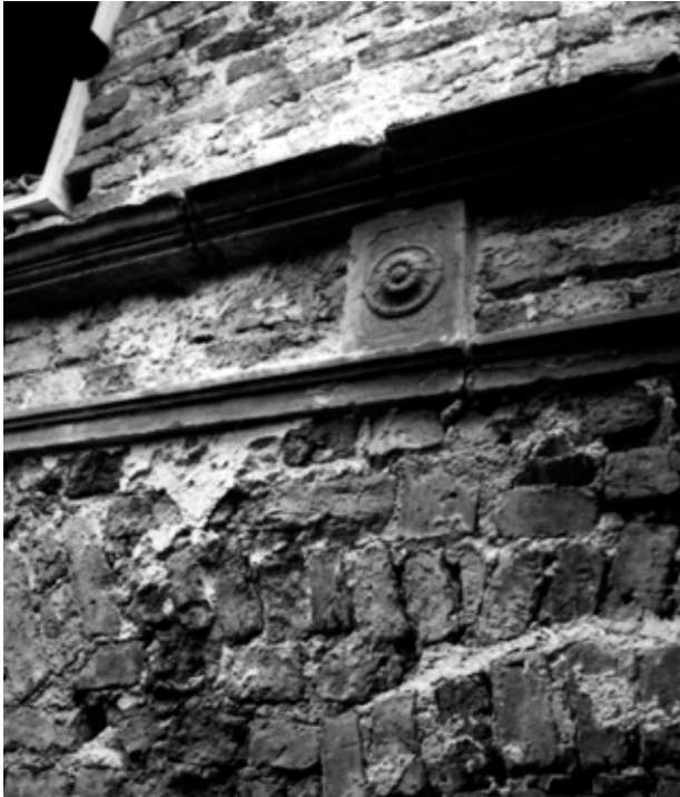
PÅ 1960-TALET TOGS METOPER AV SANDSTEN FRÅN EN TIDIGARE GAVELUTFORMNING FRAM MOT KÖPMANGATAN PÅ FASTIGHETEN PYGMALION 1. FOTO: O. EHN 1965. SSM:S ARKIV.
