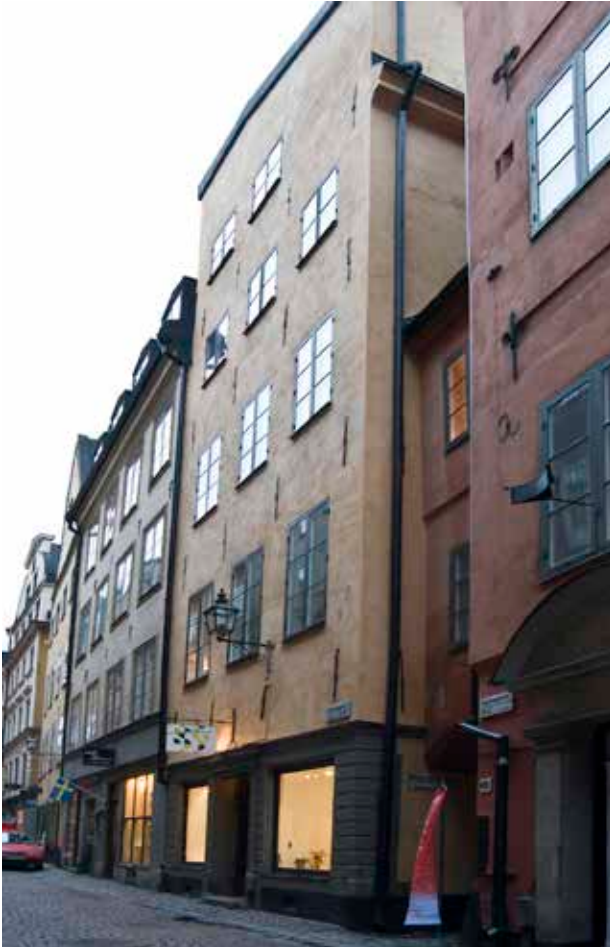
KÖPMANGATAN FRÅN ÖSTER. TILL HÖGER I BILD SKEPPAR OLOFS GRÄND MED GRÄNDÖVERBYGGNADEN SOM IDAG TILLHÖR EUROPA 6. NÄRMAST GRÄNDEN LIGGER PYGMALION 3 MED RUSTICERAD BOTTENVÅNING. FOTO: J. MALMBERG.
