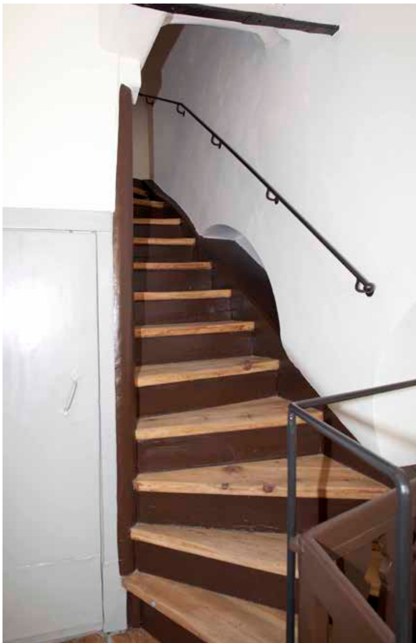
TILL HÖGER OM TRAPPAN SES DE ÖVRE DELARNA AV TVÅ BESPARINGSNISCHER I ÖSTMUREN, VILKEN I DE ÖVRE VÅNINGARNA VILAR PÅ EN KRAFTIG, HORIZONTELL BJÄLKE. I DE NEDRE VÅNINGARNA UTNYTTJAS MAN SANNOLIKT GRANNFASTIGHETENS MUR. FOTO: I. JOHANSSON, SSM.
