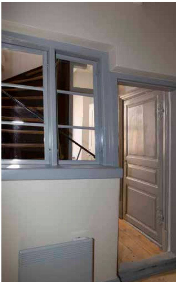
DET HALVFRANSKA DÖRRBLADET TILL HÖGER I BILD HAR GÅNGJÄRNSBESLAG FRÅN OMKRING 1700. FOTO: I. JOHANSSON, SSM.
