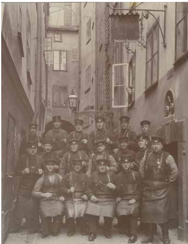
VINDRAGARLAGET UTANFÖR HÄRBÄRGET. OKÄND FOTOGRAF OCH ÅR. STOCKHOLMS STADSMUSEUMS ARKIV F 37910. MEMNON 4 SETT FRÅN SYDVÄST. DE TRE NEDRE VÅNINGARNA UPPFÖRDES PÅ 1690-TALET MEDAN DEN ÖVRE TILLBYGGDES PÅ 1760-TALET. NÅGRA AV FÖNST- REN ÄR BLINDFÖNSTER. FOTO: J. MALMBERG.
