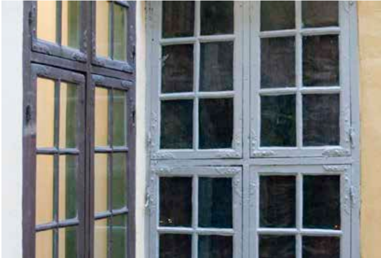
FÖNSTER FRÅN 1700-TALETS MITT MED URSPRUNGLIGA GÅNGJÄRN OCH BESLAG. FOTO: J. MALMBERG.
