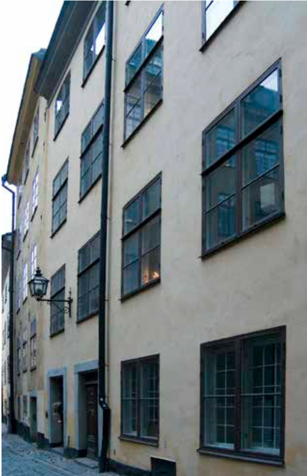
FASADEN MOT TRÄDGÅRDSGATAN ÄR SLÄTPUTSAD. I BOTTENVÅNINGEN FINNS TVÅ PORTAR MED SLÄTA STENOMFATTNINGAR FRÅN 1700-TALET. FOTO: J. MALMBERG.
