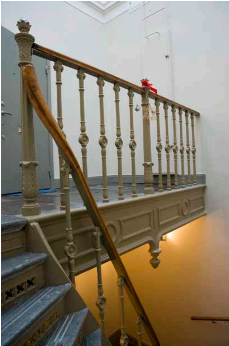
TRAPPAN AV GJUTJÄRN SATTES IN NÅGON GÅNG MELLAN 1875 OCH 1914, DÅ FASTIGHETEN INRYMDE BESIKTNINGSBYRÅN FÖR PROSTITUERADE. SLÅTA DÖRRBLAD AV METALL TILLKOM SANNOLIKT PÅ 1960-TALET. FOTO: J. MALMBERG.
