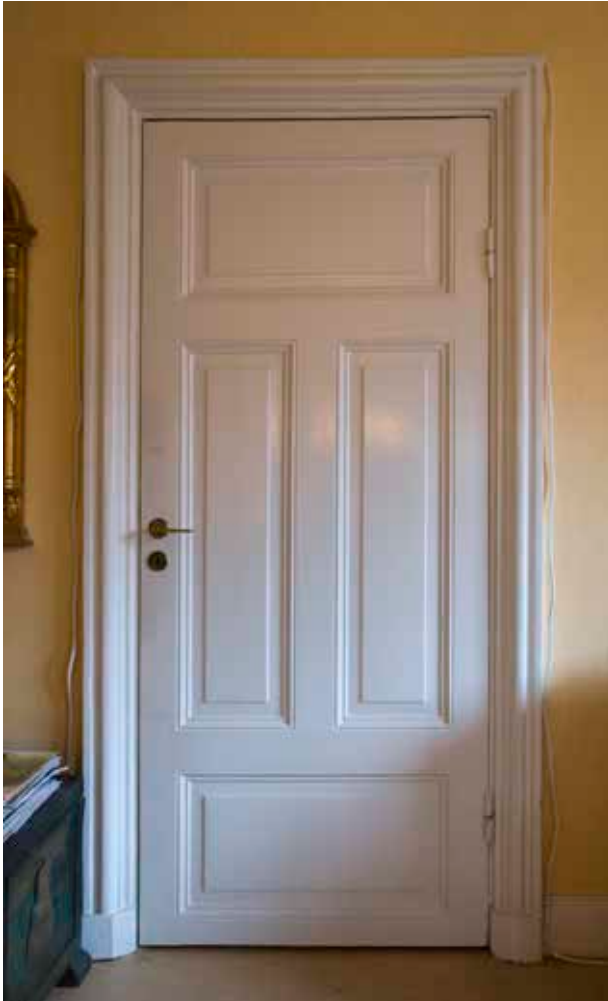
DÖRRFODRET FRÅN 1700-TALETS MITT ÅR AV ROKOKOTYP MED KRAFTIG PROFILERING, DÖRRBLADET ÄR YNGRE. FOTO: J. MALMBERG.
