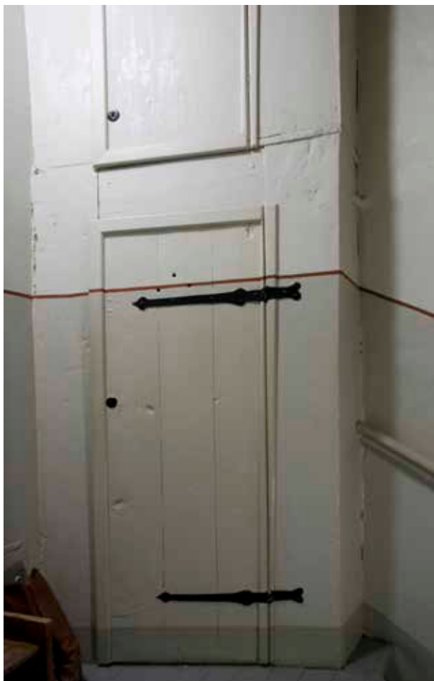
I DE ÖVRE VÅNINGARNA ÄR VILPLANENS GOLV AV TRÄ, OCH I HELA TRAPPLOPPET FÖREKOMMER ÄLDRE SKÅP SAMT NISCHER MED BRÄDDÖRRAR. FOTO: J. MALMBERG.
