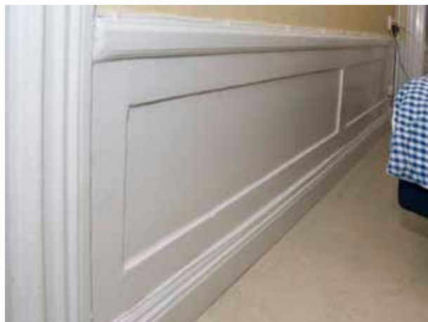
STENPROFILERAD BRÖSTPANEL FRÅN 1800-TALET. FOTO: J. MALMBERG.
