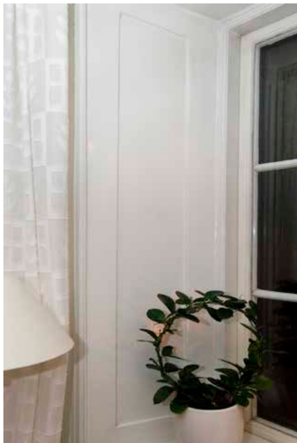
STENPROFILERAD FÖNSTERSMYGPANEL FRÅN 1800-TALET. FOTO: J. MALMBERG.
