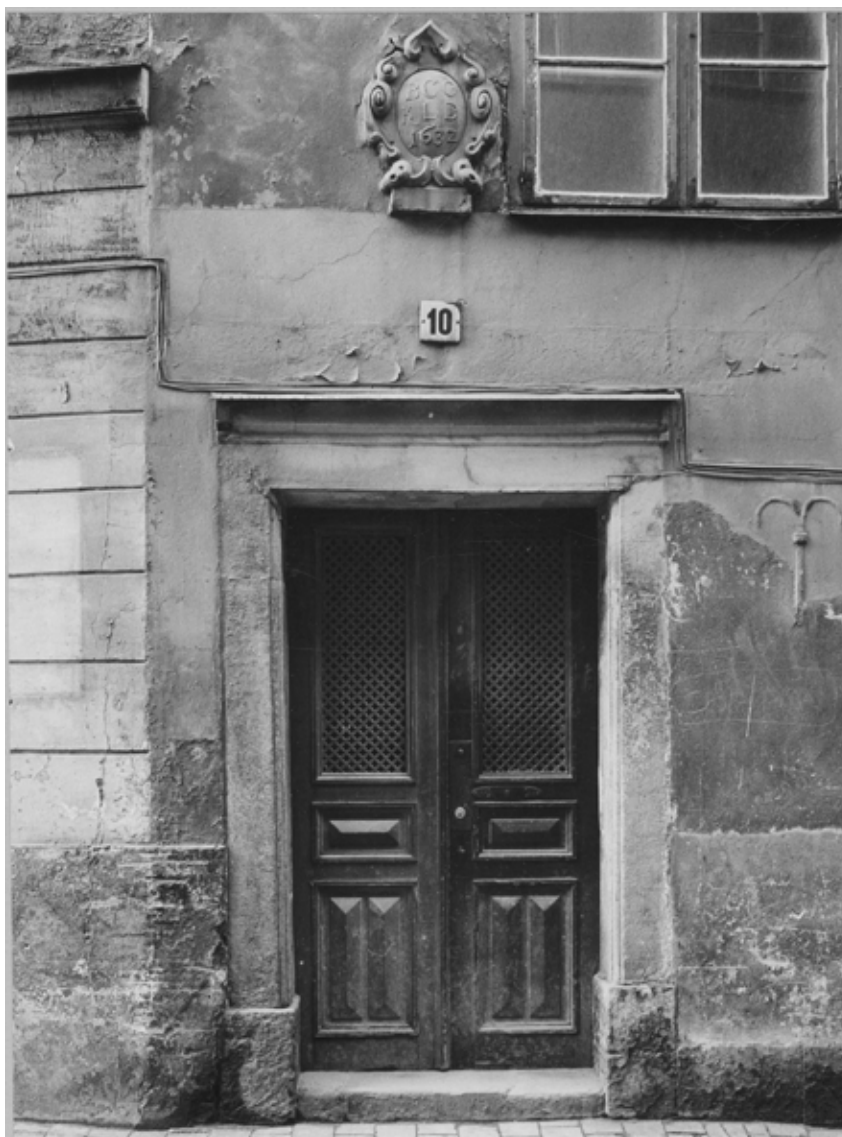
PORTEN MED OMFATTNING AV SANDSTEN OCH HELFRANSK PARDÖRR. OVANFÖR PORTEN SITTER EN SANDSTENSKARTUSCH. SSM:S ARKIV. PORTALINVENTERINGEN. PJ 1552.
