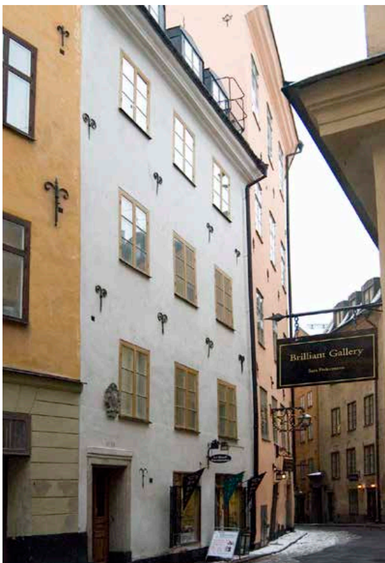
FASADEN MOT ÖSTERLÄNGGATAN ÄR SLÄTPUTSAD OCH HAR ANKARSLUTAR MED VOLUTER FRÅN 1600-TALET. FOTO: J. MALMBERG.
