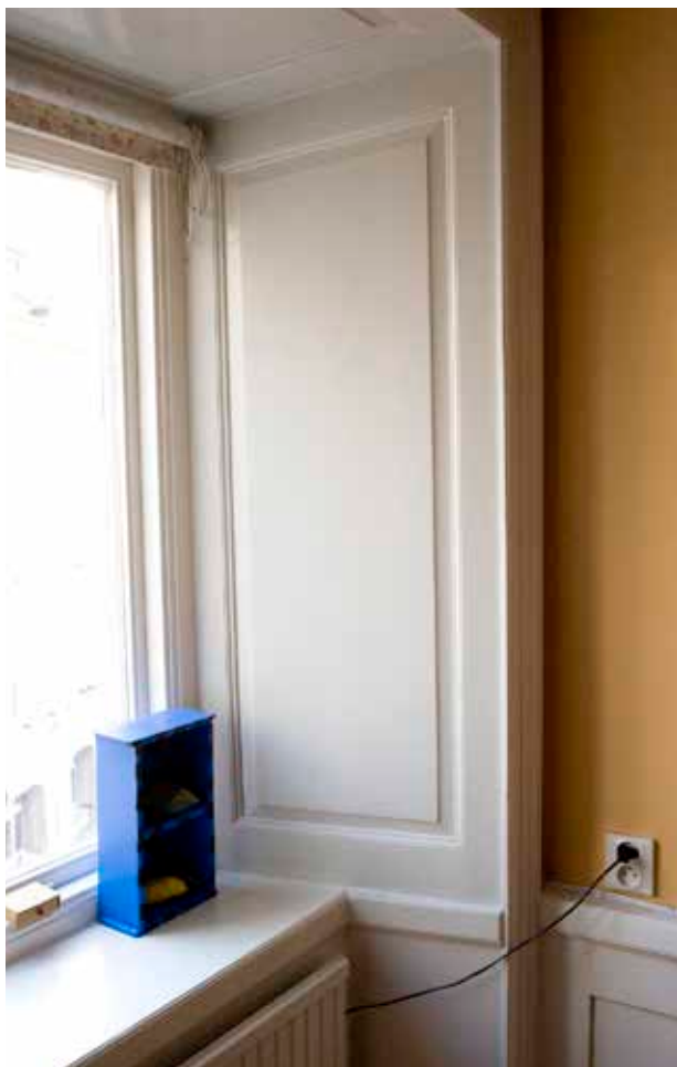
HALVFRANSK FÖNSTERMYGPANEL SAMT STENPROFILERAD BRÖSTPANEL, 1800-TAL. FOTO: J. MALMBERG.
