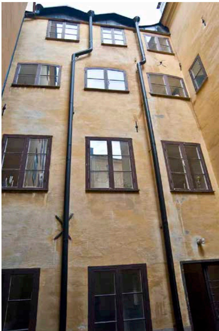
GÅRDSFASADERNA ÄR SLÄTPUTSADE MED SYNLIGA ANKARSLUTAR AV 1600-TALSTYP. FOTO: J. MALMBERG.
