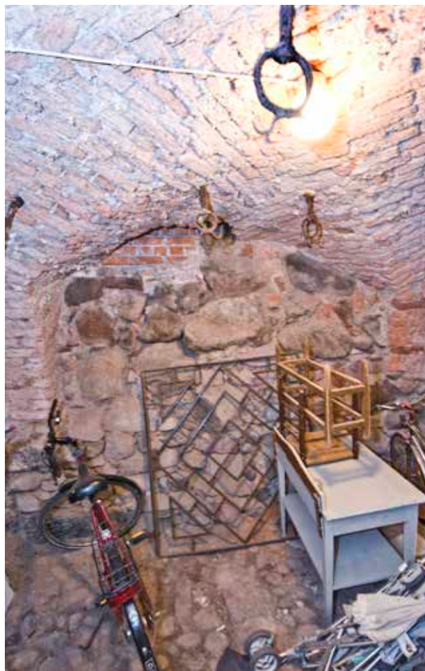
KÄLLARRUM MED KULLERSTENSGOLV. TEGELVALVET ÄR SENARE ÄN KÄLLARRUMMET, FÖRMODLIGEN FRÅN OMBYGGNADEN 1760. FOTO: J. MALMBERG.
