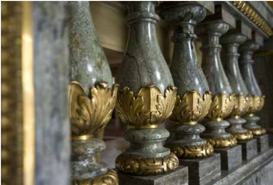
TRAPPRÄCKETS BALUSTERDOCKOR ÄR UTFÖRDA I KOLMÅRDSMARMOR MED FÖRGYLDA BRONSBESLAG, EFTER BESTÄLLNING FRÅN HOVJUVELERAREN JEAN JAHNSSON OMKRING 1905. FOTO J. MALMBERG.
