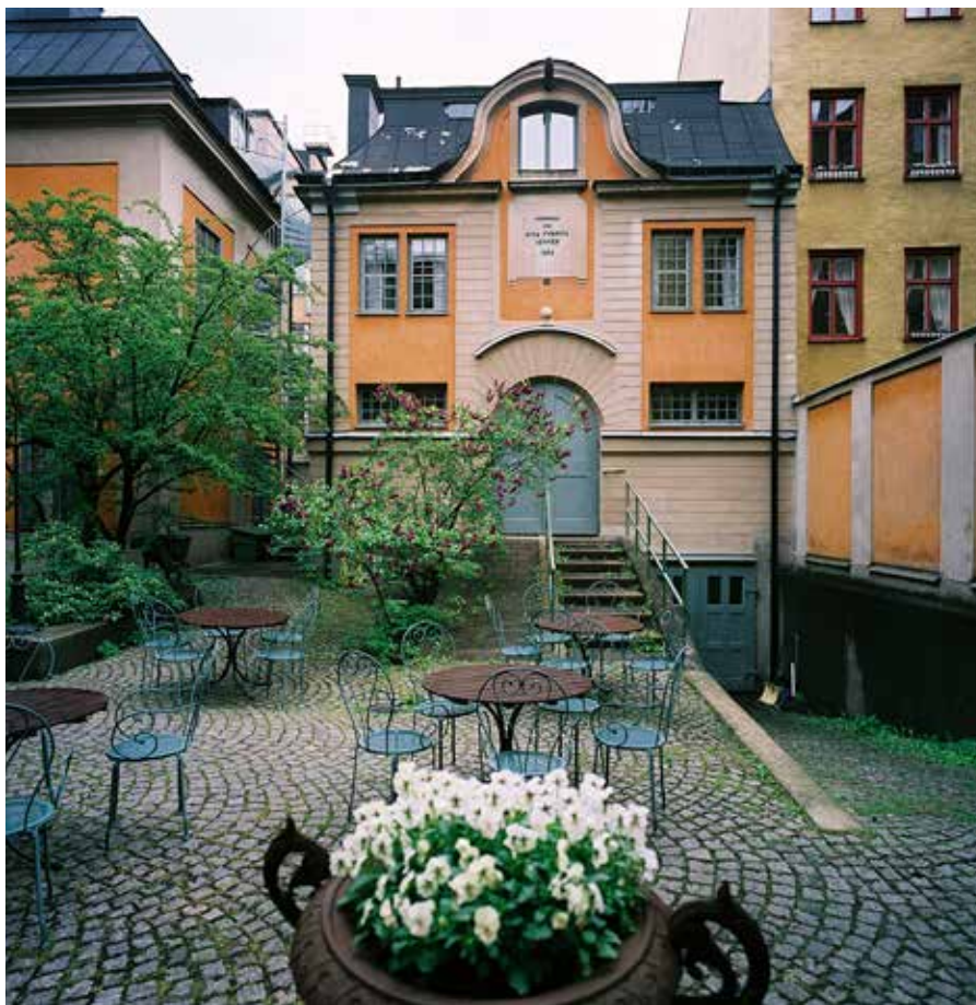
INNE PÅ GÅRDEN STÅR STALLET, UPPFÖRT 1903 - 1906 OCH URSprung- LIGEN INRETT MED VAGNS-RUM I KÄLLAREN, SPILTOR INNANFÖR PORTEN I BOTTENVÅNINGEN, KUSBOSTAD PÅ VÅNING 1 TRAPPA OCH HÖSKULLE ÖVERST. FOTO G. FREDRIKSSON, SSM.
